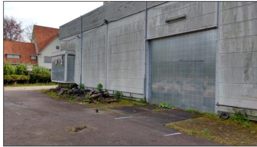
De te slopen bedrijfshallen van de voormalige brouwerij.
