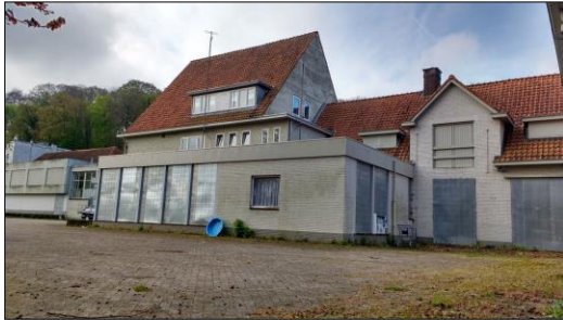
Het te slopen ontvangstgebouw.
