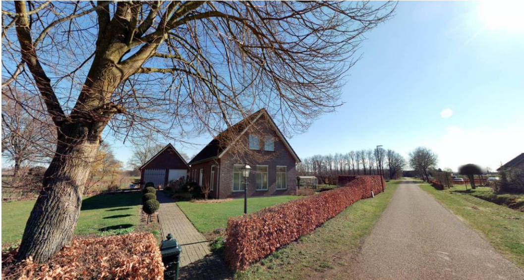
Figuur 4: Bestaande woning op het perceel Breestraat 1
