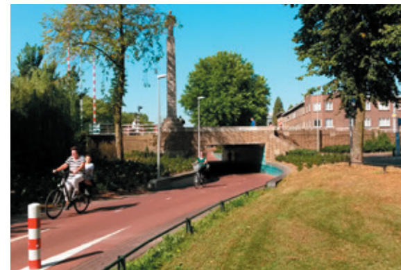
Nieuw toegevoegde fietsonderdoorgang Spinozabrug
