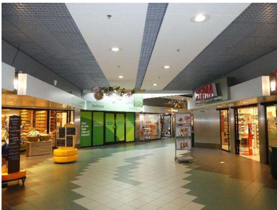
Het saaie en lage plafond beperkt de belevingswaarde van het winkelcentrum.
