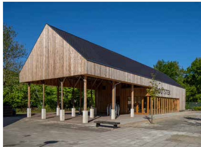
Houten schuurvolume buiten de vesting
