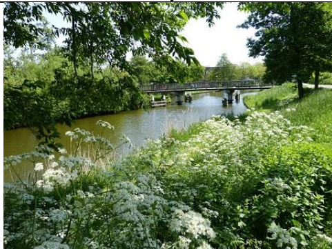
Verlegde Strijp in Honselersdijk
