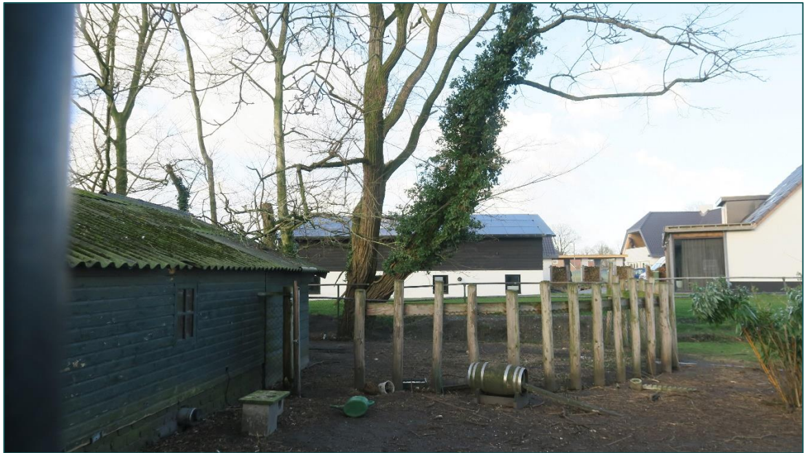
Figuur 3 Schuur 3 wordt volledig gesloopt.
