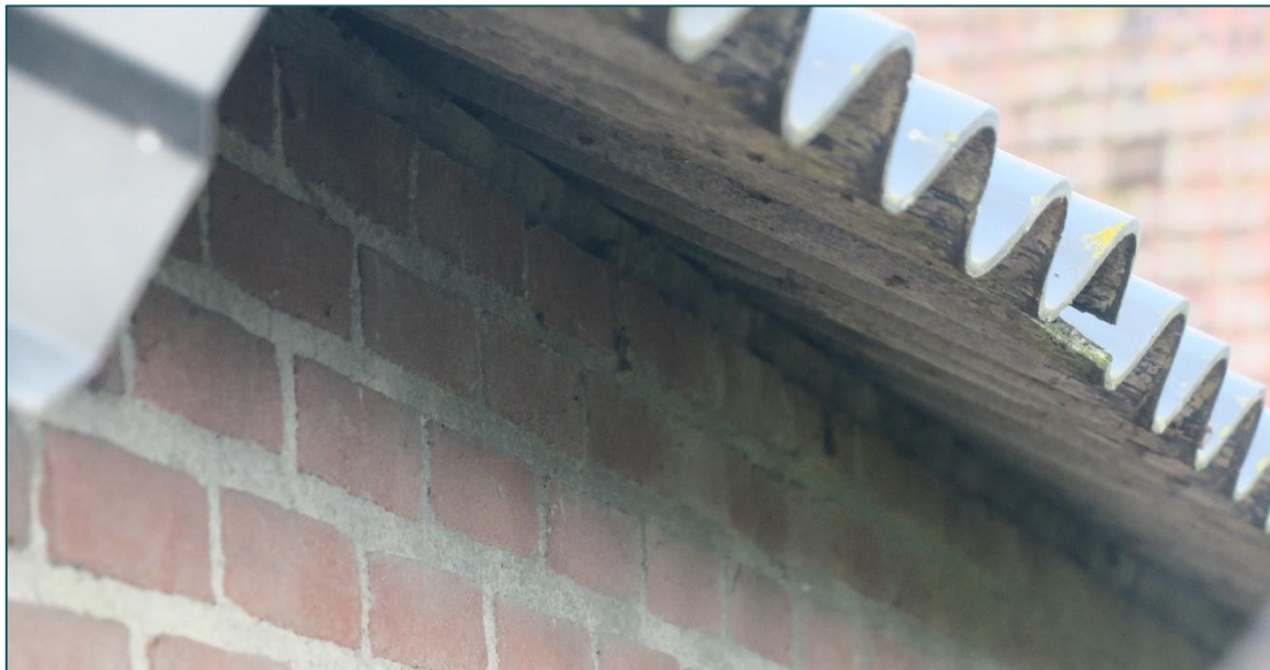
Figuur 3.1 Onder het golfplaten dak is een betonnen rand gemaakt die de ruimte onder de golfplaten afsluit van de buitenzijde.
