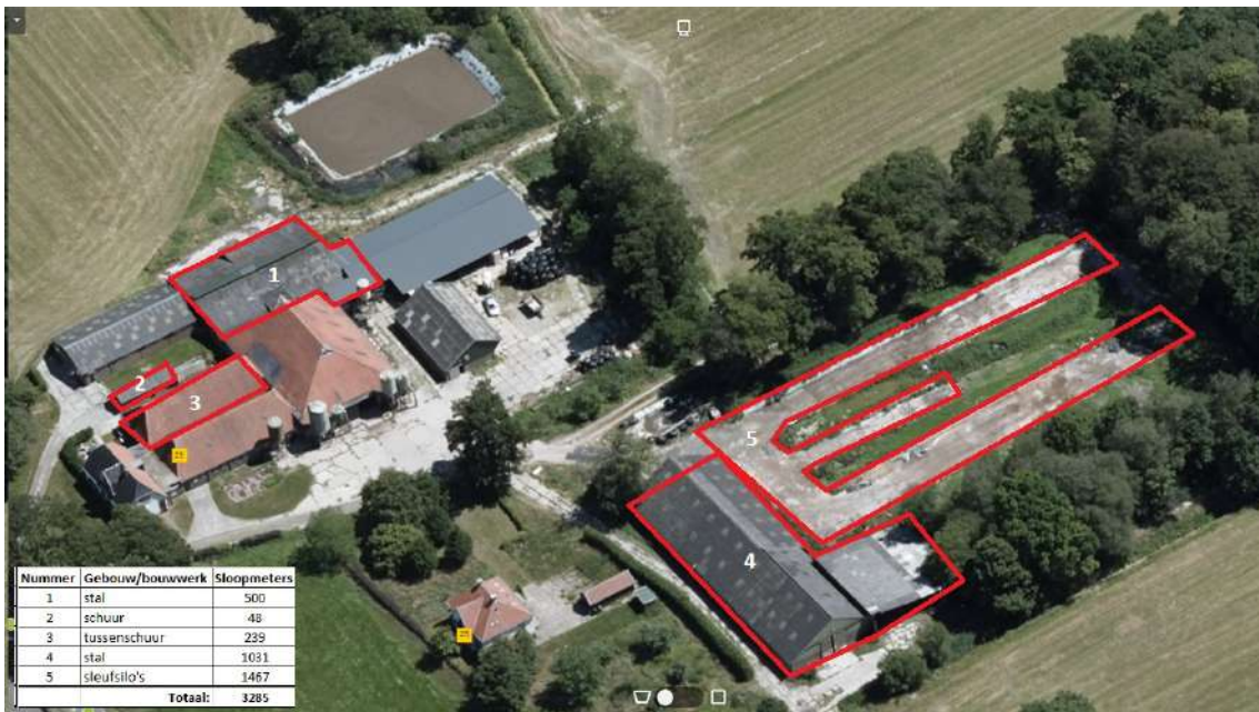
Figuur: Sloopmeters Bovenweg nr. 23 en nr. 25
