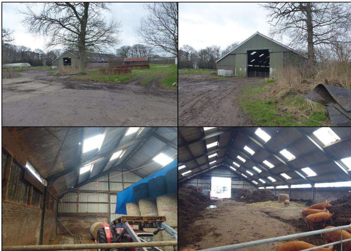
Figuur I.1. Te slopen varkensstal (nr. 1).
