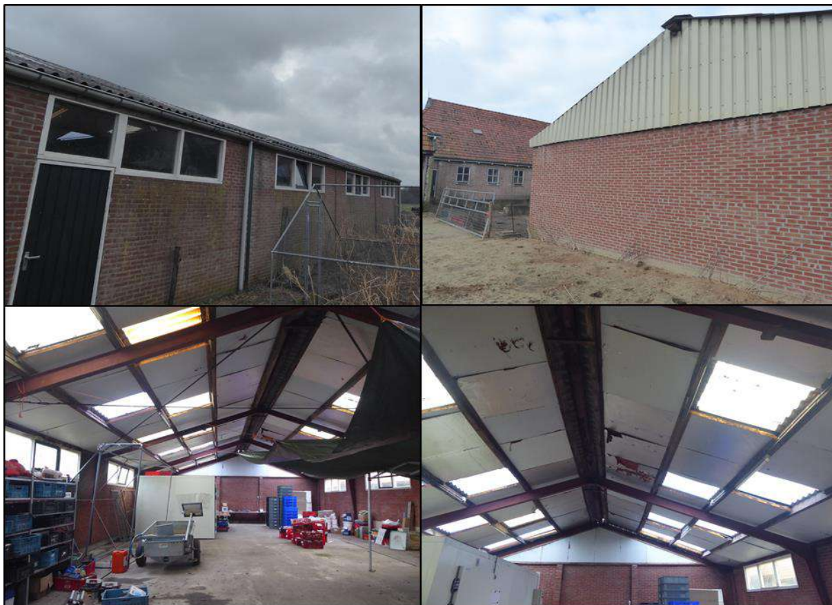
Figuur I.6. Te slopen loods (nr. 6).
