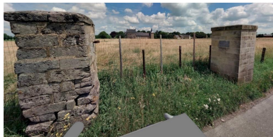
Hekpijlers aan de Kenkersweg in Sibbe
