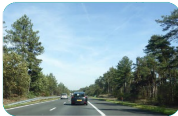
A28 als energieroute onderzocht.
