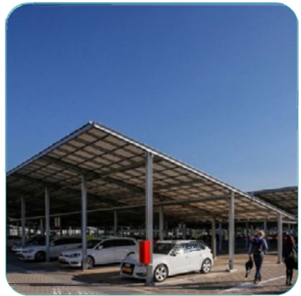
Parkeerterrein op defensie terrein, overkapt met zonnepanelen.
