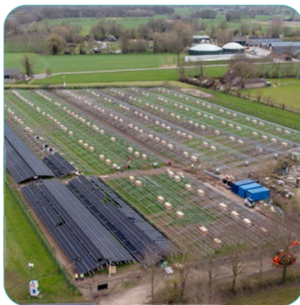
Aanbouw zonnepanelenveld bij Aalbertshoeve in Ermelo - april 2021
