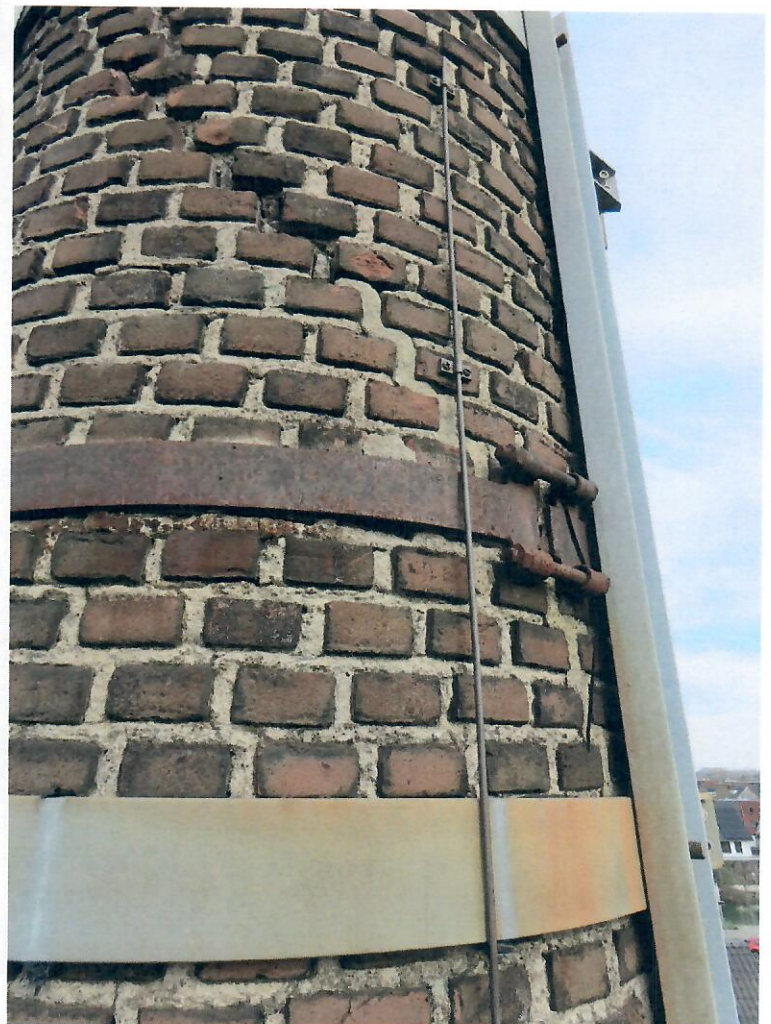
Voegwerk door weersinvloeden aangetast, en scheurvorming door ingemetseld ijzerwerk.
