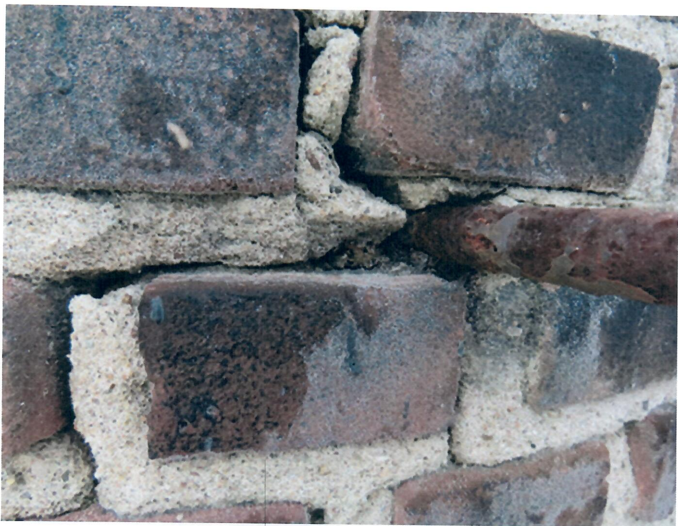
Eveneens schade aan metselwerk door roestvorming aan stalen buiten klimijzers.
