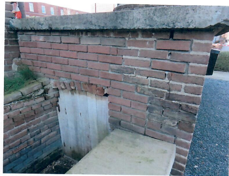
Behoudens lichte scheurvorming, verkeerd het metselwerk van basement in vrij goede staat
