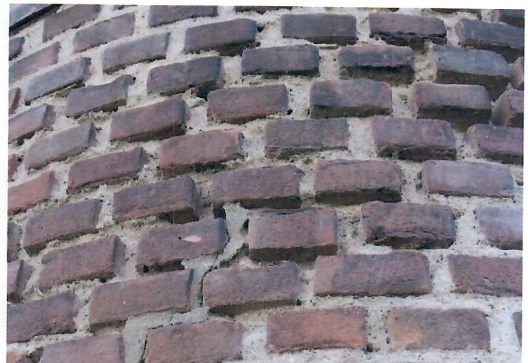
Voegwerk in onderste deel van de schacht, door weersinvloeden aangetast.
