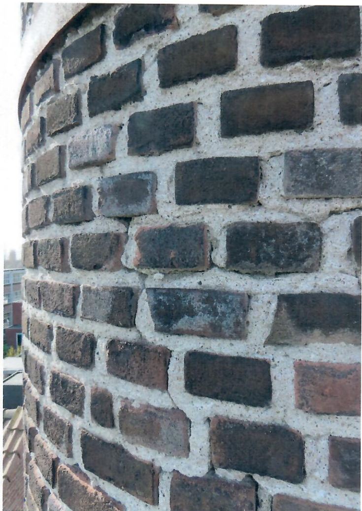
Voegwerk licht tot sterk door weersinvloeden aangetast, en zijn door roestvorming aan ingemetseld ijzerwerk, scheuren in het metselwerk ontstaan.
