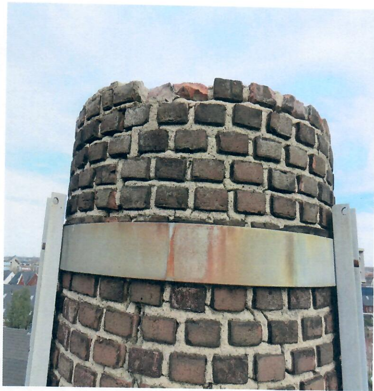
Bovenste los liggende laag metselwerk is tijdens de inspectie van de schoorsteen afgenomen.
