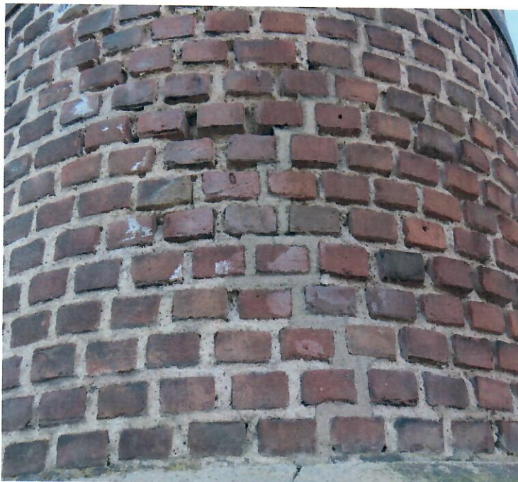
Voegwerk in onderste deel van de schacht, door weersinvloeden aangetast.
