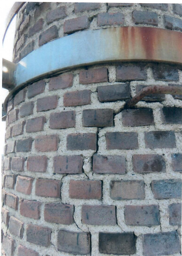
Door roestvorming aan de stalen buiten klimijzers, zijn scheuren in het metselwerk ontstaan
