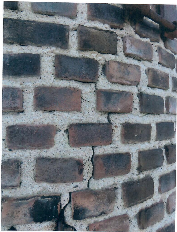
Eveneens schade aan metselwerk door roestvorming aan ingemetseld ijzerwerk.
