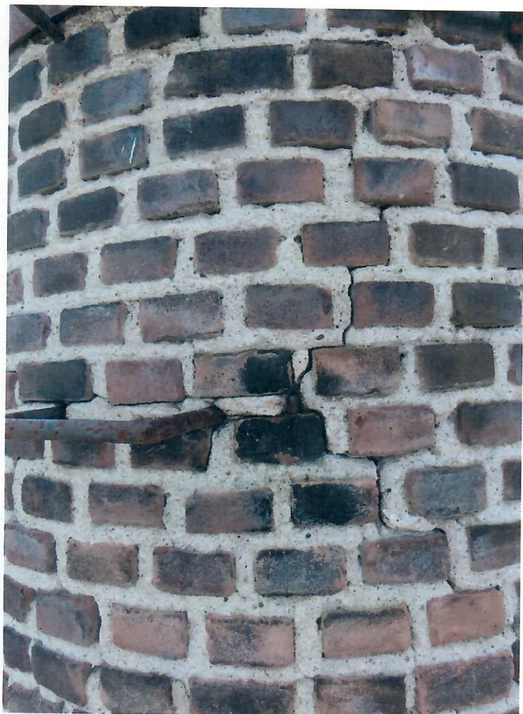
Eveneens scheurvorming in het metselwerk van de schacht, door roestvorming aan in gemetselde stalen buiten klimijzers.
