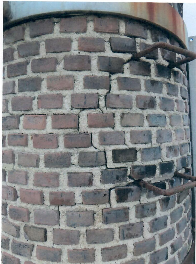
Eveneens door weersinvloeden aangetast voegwerk en scheurvorming door roestvorming aan ingemetseld ijzerwerk.
