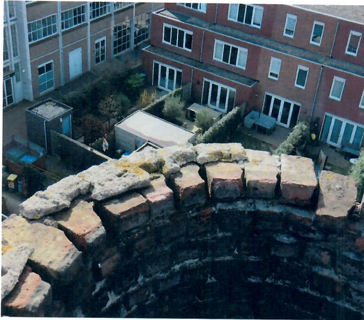
Bovenste los liggende laag metselwerk is tijdens de inspectie van de schoorsteen afgenomen.
