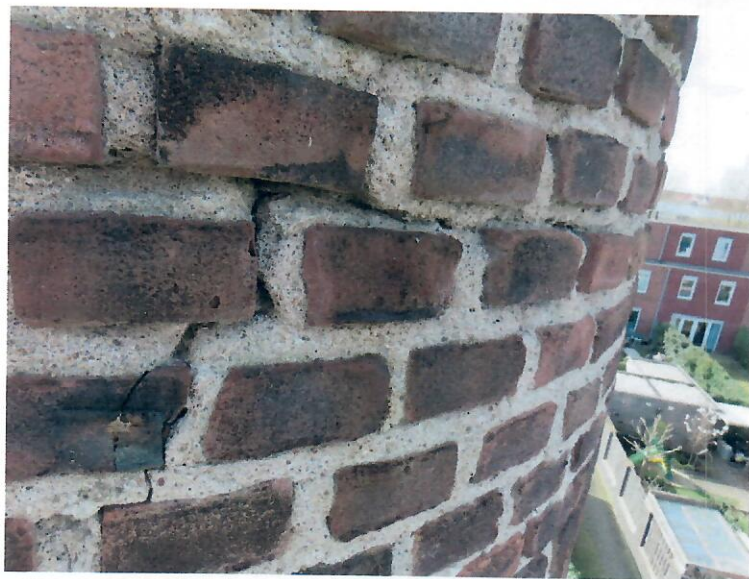
Eveneens scheurvorming in het metselwerk van de schacht, door roestvorming aan in gemetselde stalen buiten klimijzers.
