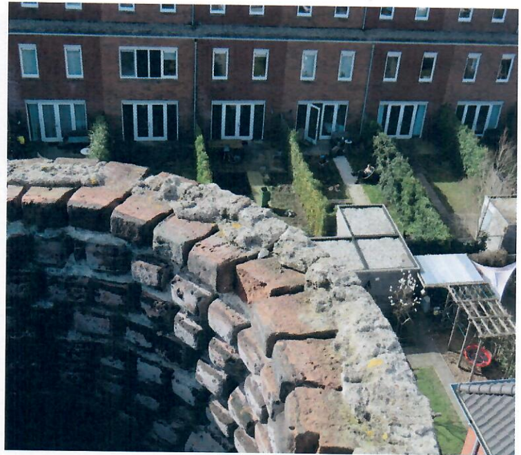
Bovenste los liggende laag metselwerk is tijdens de inspectie van de schoorsteen afgenomen.
