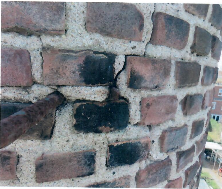
Eveneens schade aan metselwerk door roestvorming aan ingemetseld ijzerwerk.
