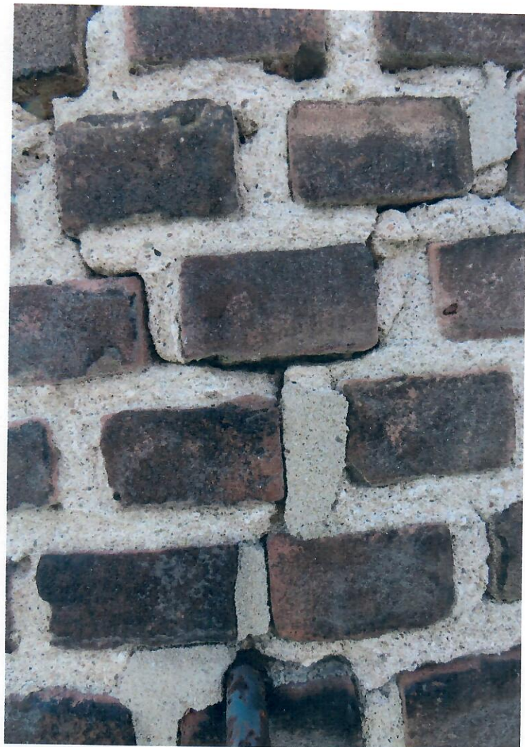
Eveneens scheurvorming in het metselwerk van de schacht, door roestvorming aan in gemetselde stalen buiten klimijzers.
