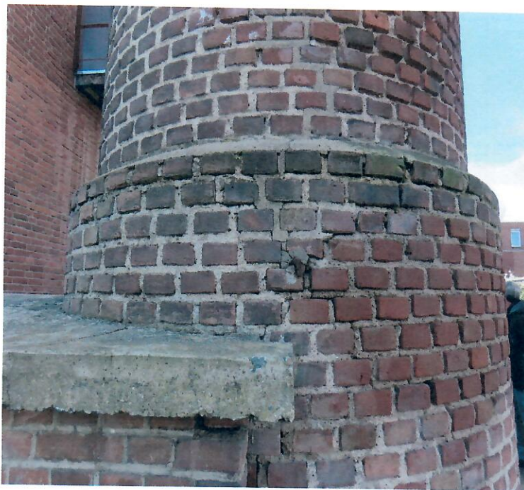
Behoudens lichte scheurvorming, verkeerd het metselwerk van basement in vrij goede staat
