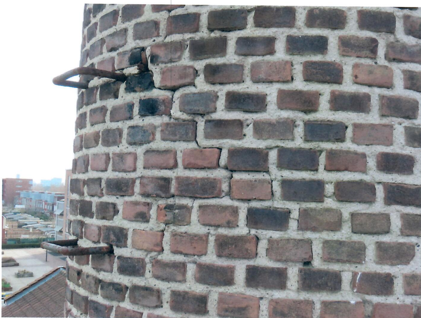
Eveneens schade aan metselwerk door roestvorming aan stalen buiten klimijzers.
