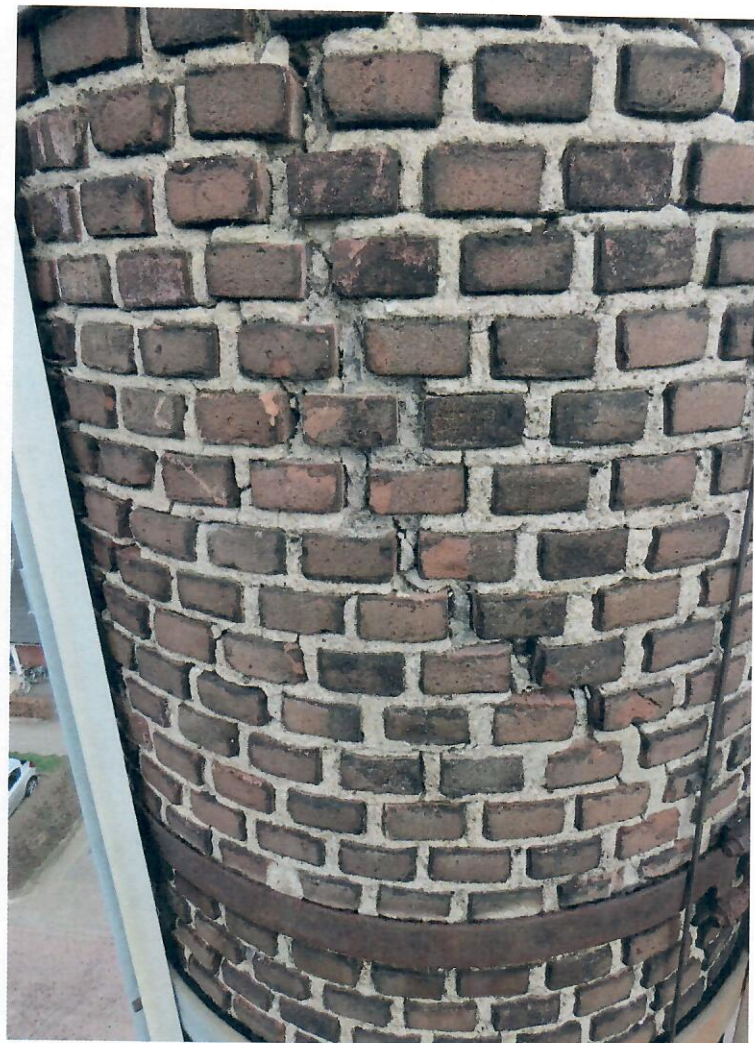
Eveneens door weersinvloeden aangetast voegwerk en scheurvorming door roestvorming aan ingemetseld ijzerwerk.
