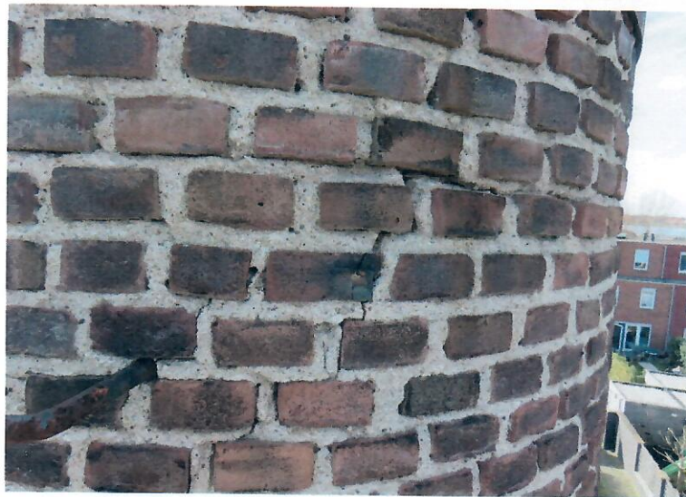
Voegwerk licht tot sterk door weersinvloeden aangetast, en zijn door roestvorming aan ingemetseld ijzerwerk, scheuren in het metselwerk ontstaan.
