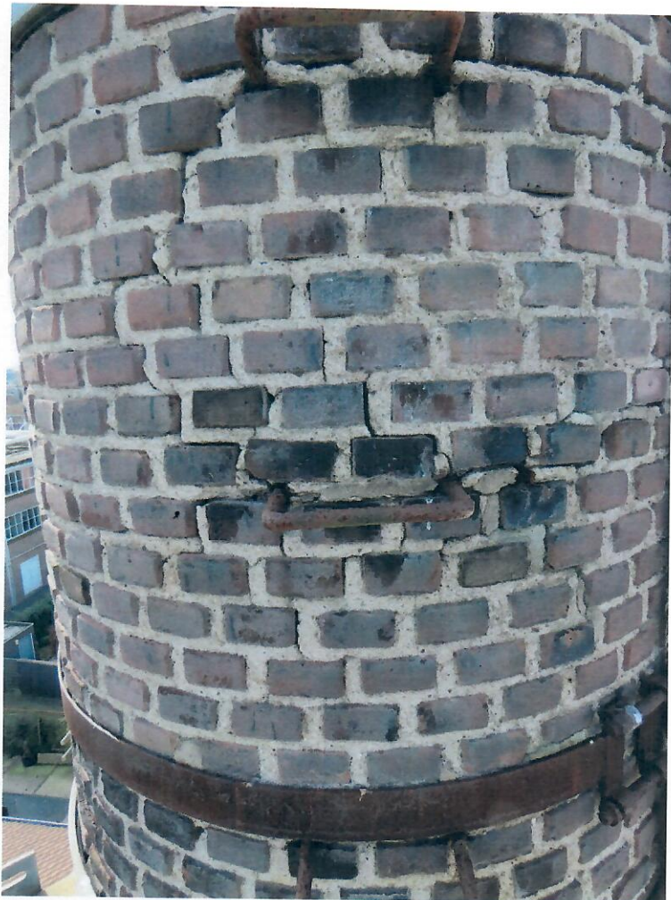
Door roestvorming aan de stalen buiten klimijzers, zijn scheuren in het metselwerk ontstaan
