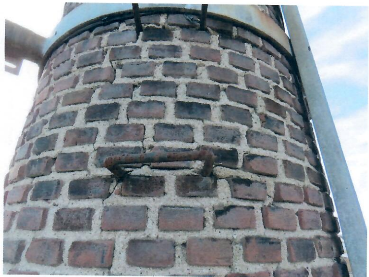
Eveneens schade aan metselwerk door roestvorming aan ingemetseld ijzerwerk.
