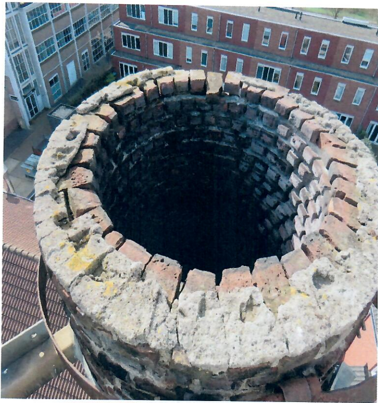
Bovenste los liggende laag metselwerk is tijdens de inspectie van de schoorsteen afgenomen.
