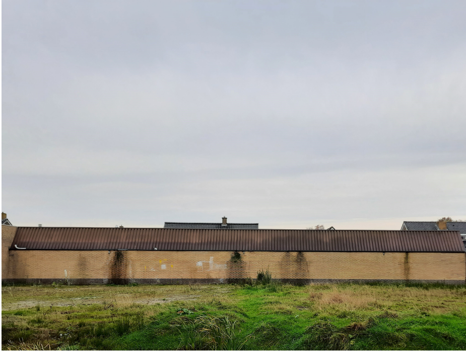
Figuur 5: overzicht loods projectgebied
