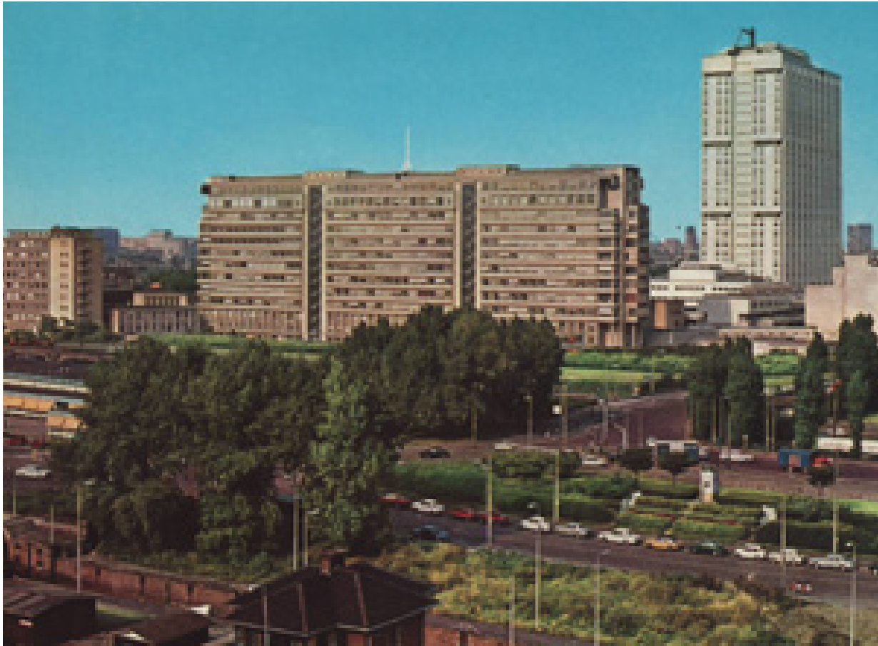
Voormalig gesloopt ziekenhuis, locatie SPOT - bron: Land van Hoboken - uit Cultuurhistorische verkenning Urban Fabric | Steenhuis stedenbouw/landschap
