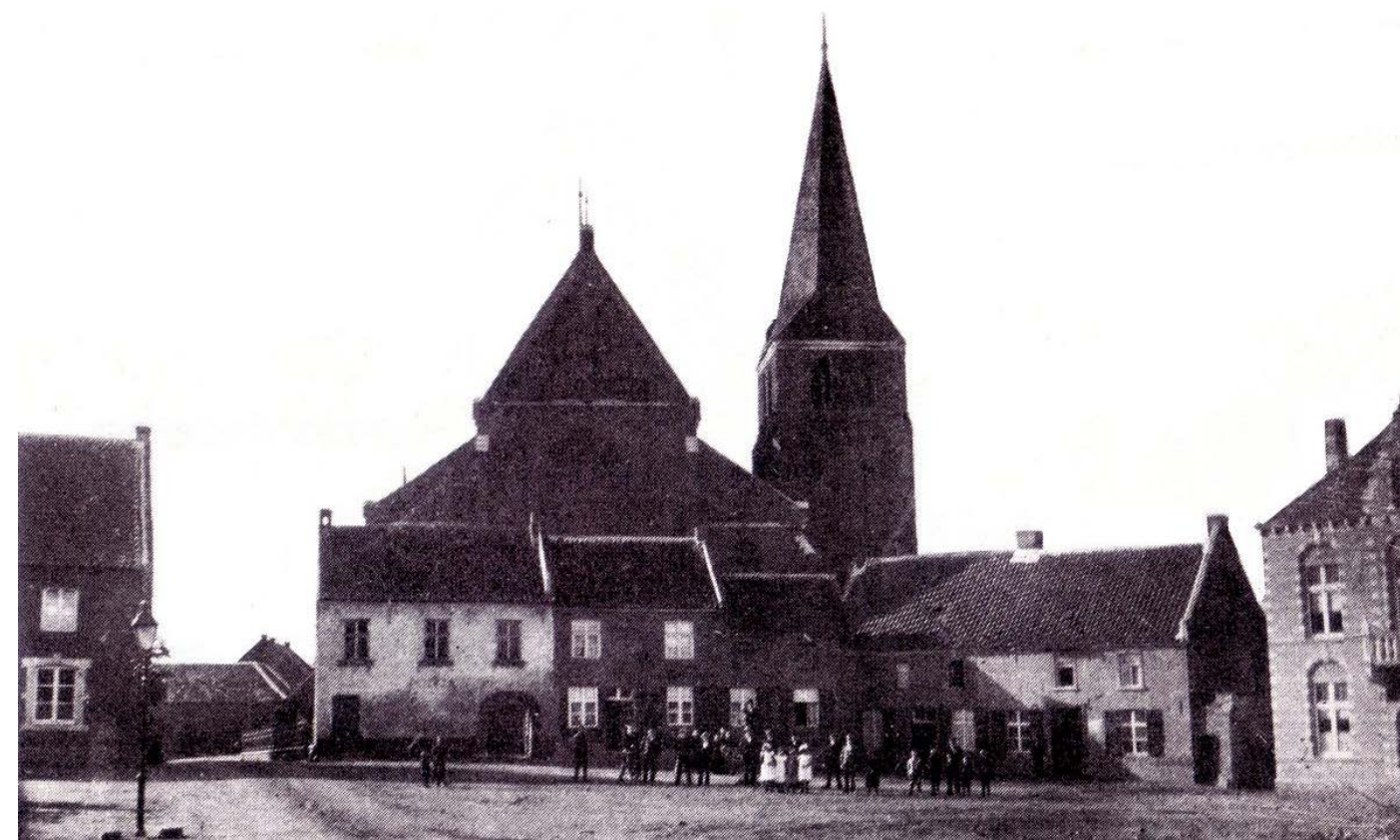
5 | Lambertuskerk verbinding via poortgebouw aan het marktpluin (ca. 1900)
