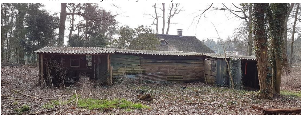
Foto 6. Eén van de opstallen op Landgoed De Polberg waarin nesten van bepaalde vogels, steenmarter en egel aanwezig kunnen zijn
