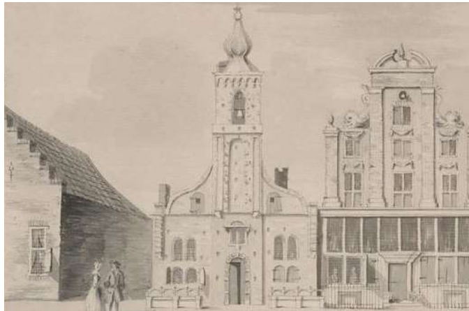
Tekening van het 'Oude Stadhuis' te Edam. Hiermee wordt het pand met het torentje bedoeld. Dit gebouw is onderdeel van het in 1400 gestichte St. Elisabethgasthuis. Aan de linkerkzijde is de Gasthuissteeg te zien. Later is op de locatie van het gasthuis en de Gasthuissteeg de Lutherse kerk gebouwd.
