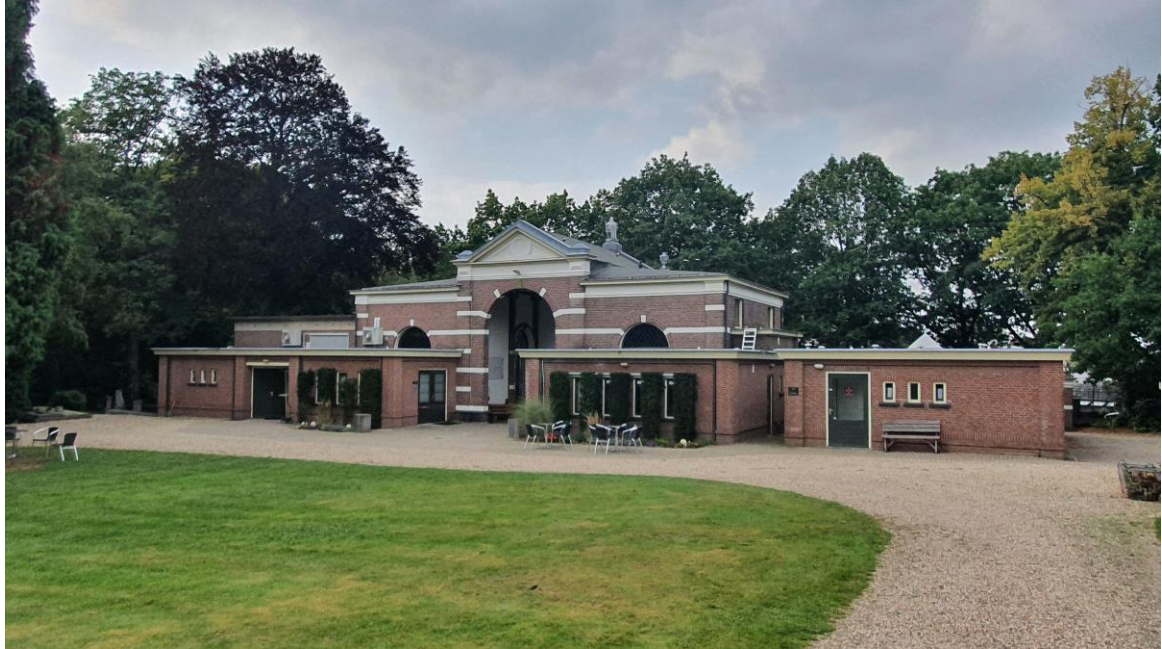
Poortgebouw vanuit het zuiden.
