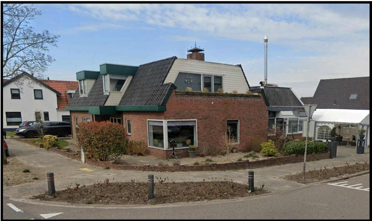
De bestaande panden aan de Dorpsweg 22-24. Hoogte boven begane grond niveau circa 6,60 meter. (bron: Google Street View)
