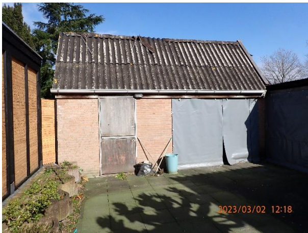
Foto 3: links, dit is een schuurtje zonder dakbeschot.
