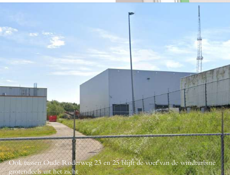
Het begroeide gronddepot op het naast gelegen terrein
