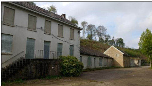
Bebouwing langs de Plenkertstraat, gezien vanaf het plangebied in zuidwestelijke richting.
