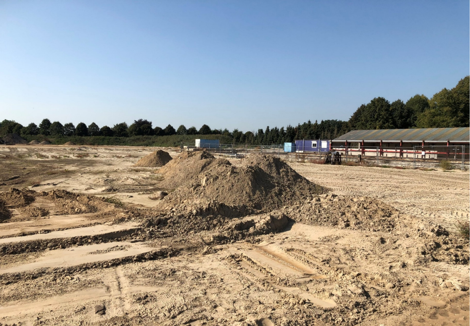
Afbeelding: Grondwerkzaamheden ten behoeve van zonnenveld 'De Branderwal' bij Kootwijkerbroek.
