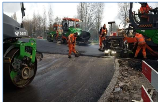
Hoofdinfrastructuur - Werk in uitvoering
