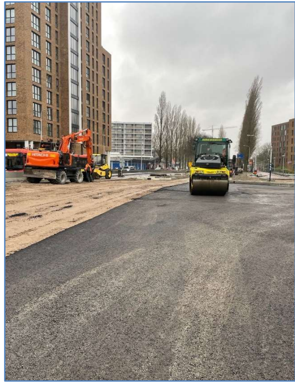
Hoofdinfrastructuur - Werk in uitvoering
