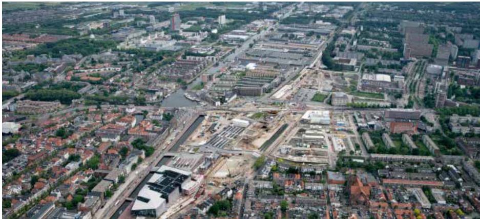
Spoorzona Delft, spoor ondergronds gebracht
