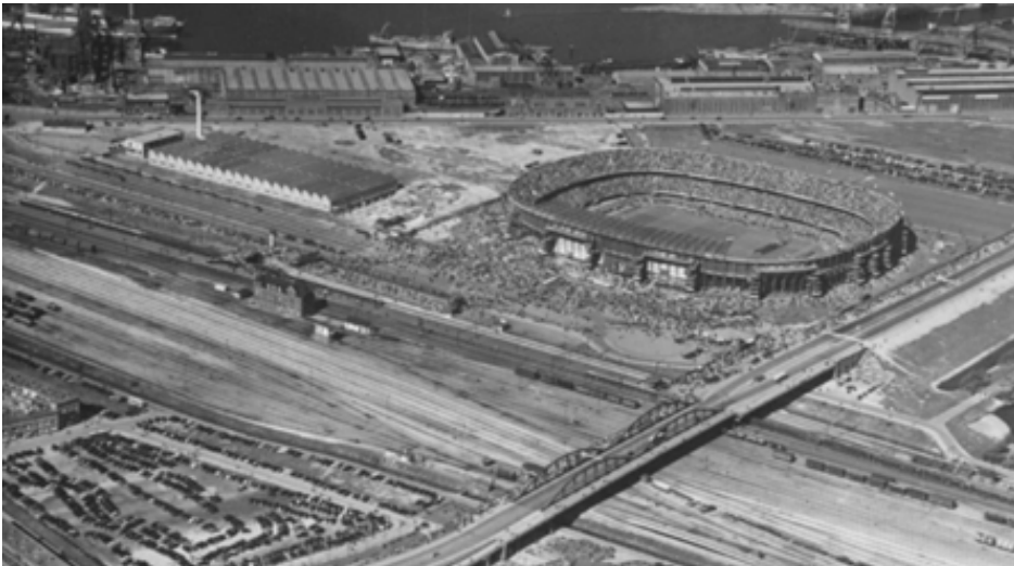
Stadion Feyenoord met op de voorgrond de Breebrug in 1949. De hoofdoriëntatie op het westen, op de stadswijken van Zuid is hier duidelijk te zien. (bron: Stadsarchief Rotterdam)
