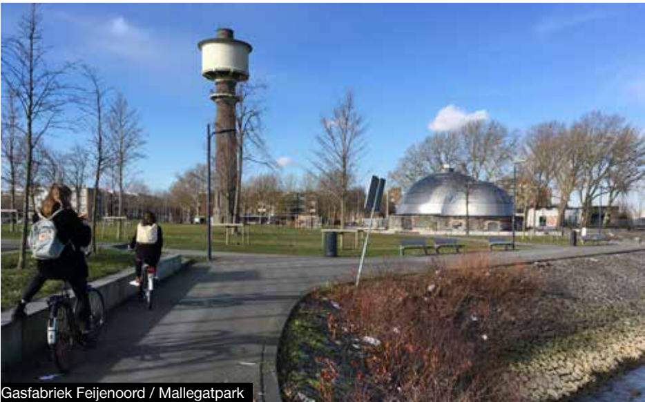
Gasfabriek Feijenoord / Mallegatpark
