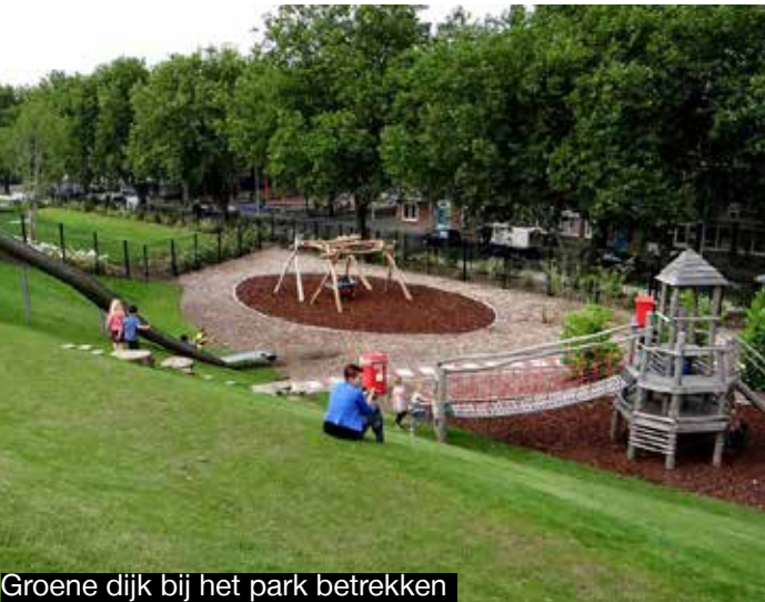
Groene dijk bij het park betrekken Dakpark, Rotterdam
