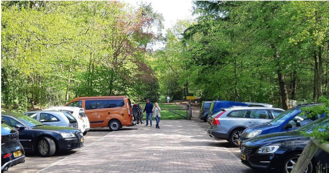
Referentie parkeren in het groen, rijbaan van gebakken klinkers en de parkeerplaatsen van halfverharding
