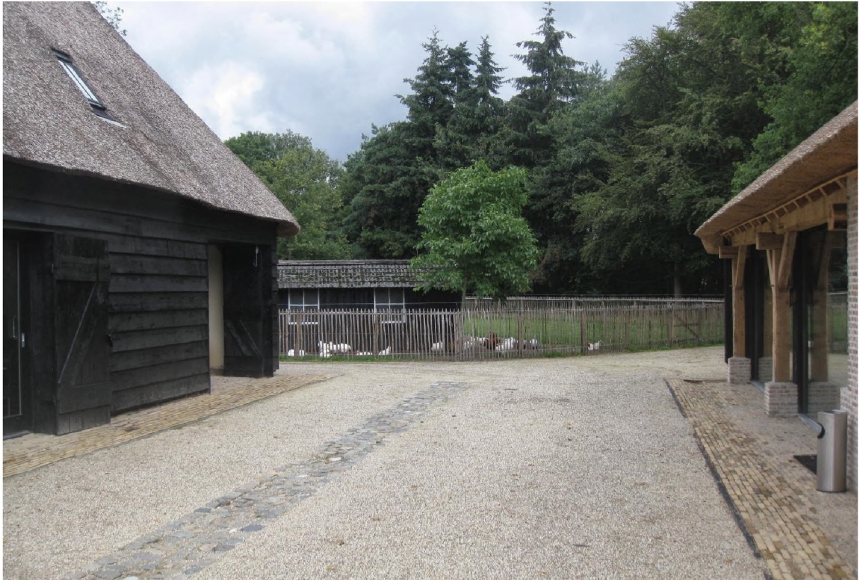
Referentie terreinafwerking: combinatie halfverharding met natuursteen en gebakken klinkers
