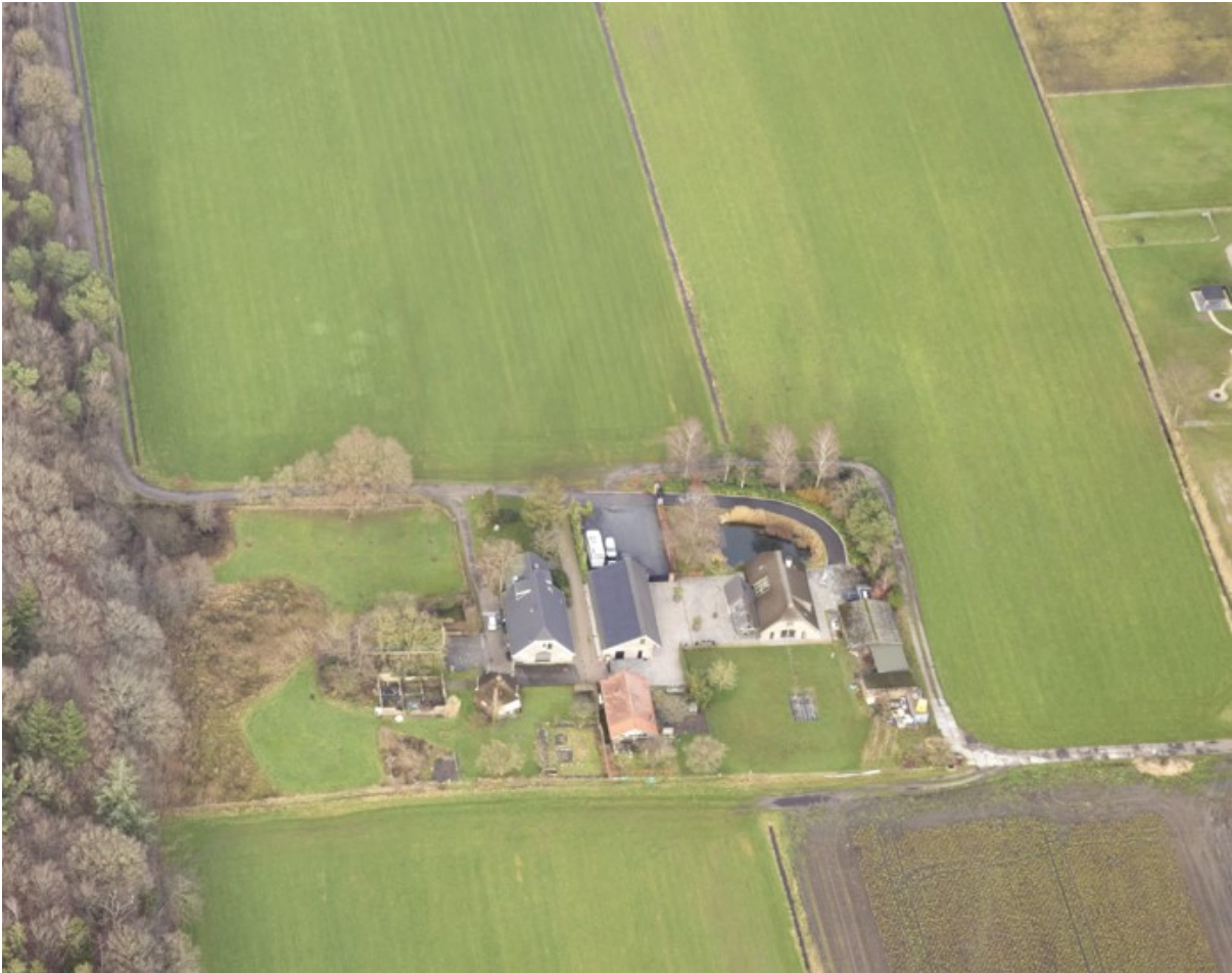
Impressie deelgebied 2, gezien vanaf een bovenaanzicht (noordelijke gedeelte)
