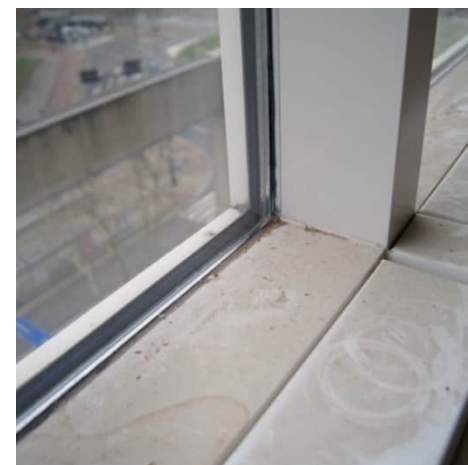
Voor de aluminium kozijnen uit 1987 is op de achtste bouwlaag een borstwering gezet.
