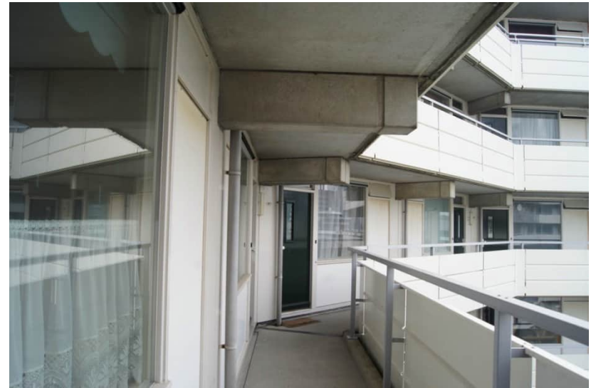
De prefab betonelementen definiëren het ritme van de galerij.
