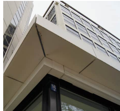
Betonnen overstek met aluminium afdekking, voorzijde plint
