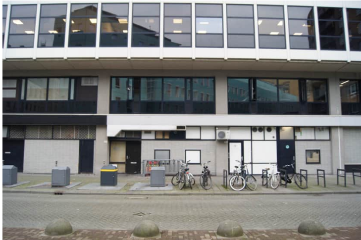
De plint van de achtergevel heeft het karakter van een achterzijde.
