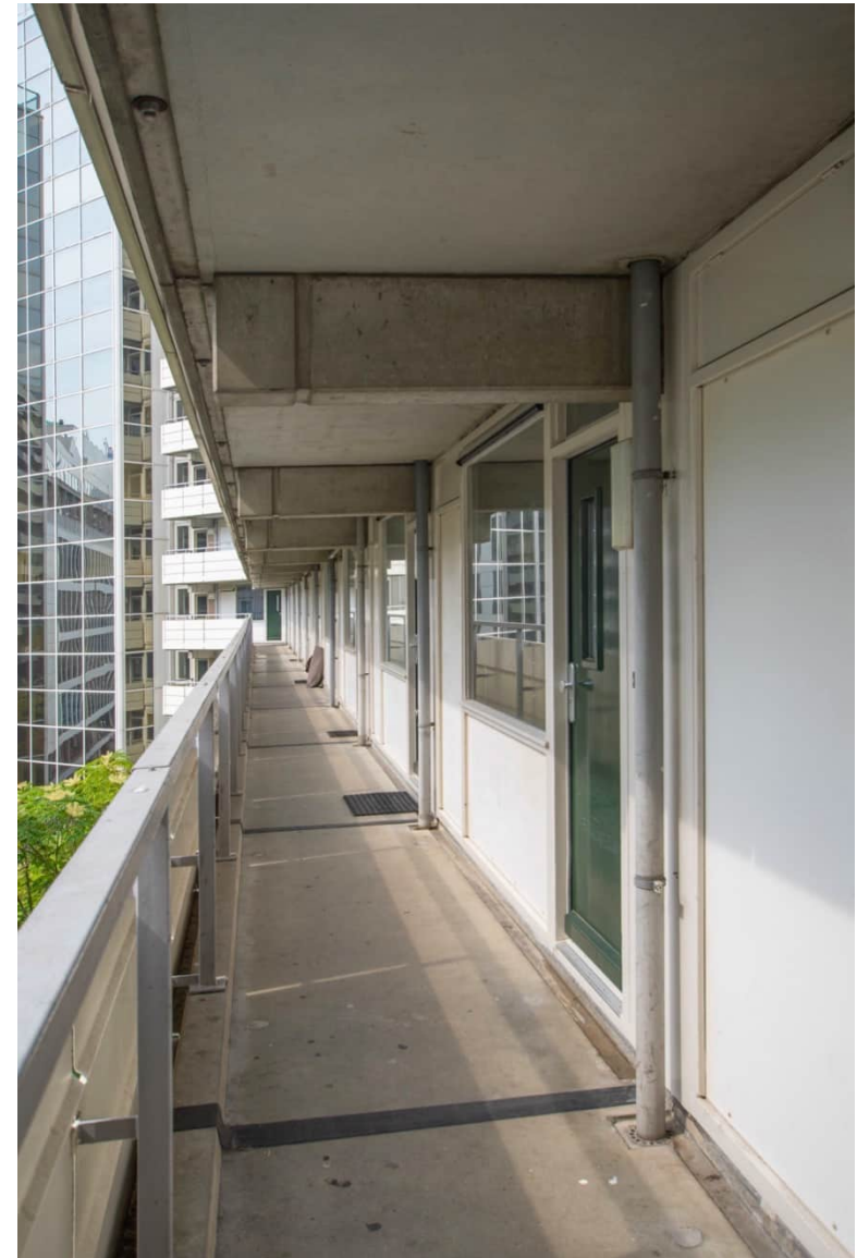
De galerijen met betonskelet in zicht.
