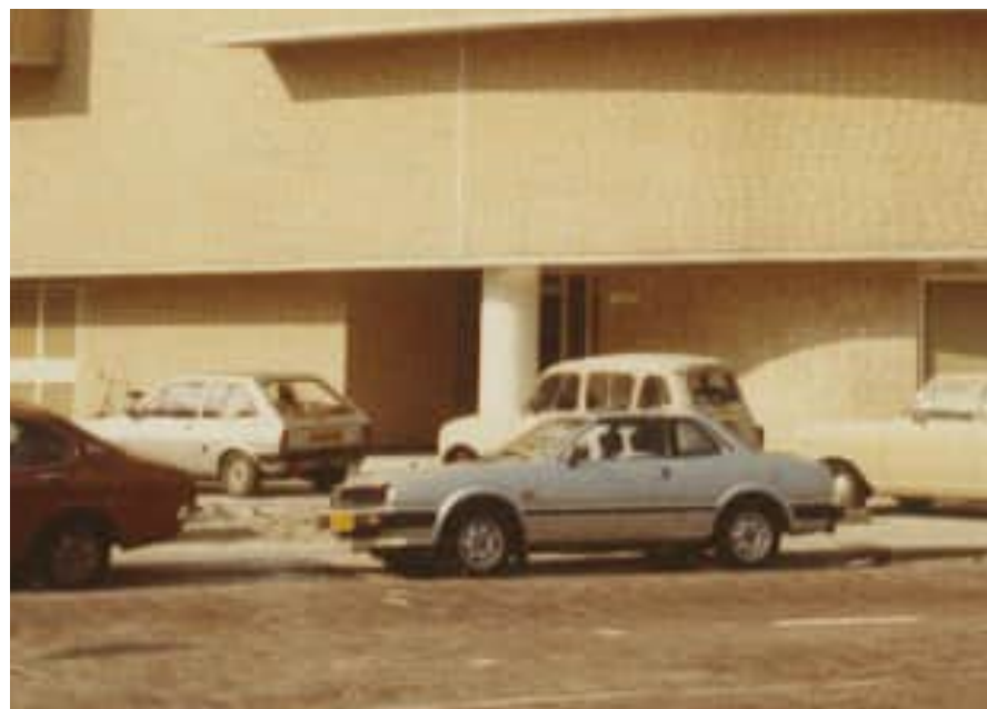
Te zien is de oorspronkelijke situatie van de entree.
