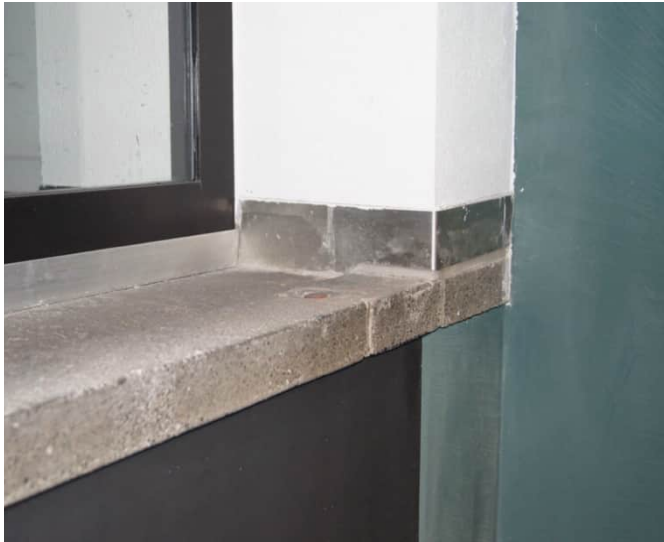
De vensters op de derde t/m zesde bouwlaag aan de achterzijde ter hoogte van het trappenhuis hebben een tweedeling.
