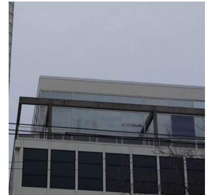
Een betonnen pergola markeert bovenste bouwlagen.
