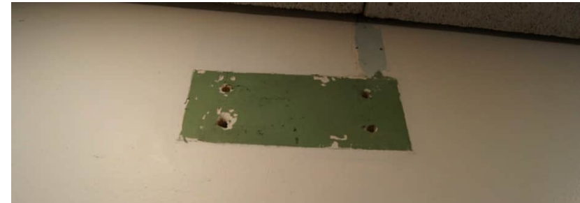
Groene verlaag onder witte laag in trappenhuis zijde doelstraat; onduidelijk om welke verlaag het hier gaat.
