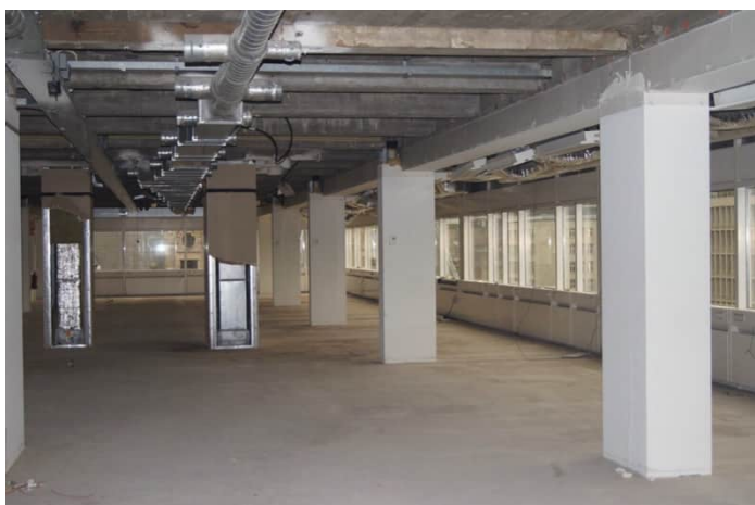
De achtste bouwlaag is volledig gestript. De structuur van de betonnen pijlers is nog aanwezig.
