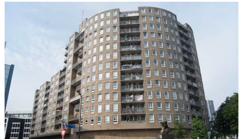
Voorgevel zijde Haagseveer/Doelstraat.
