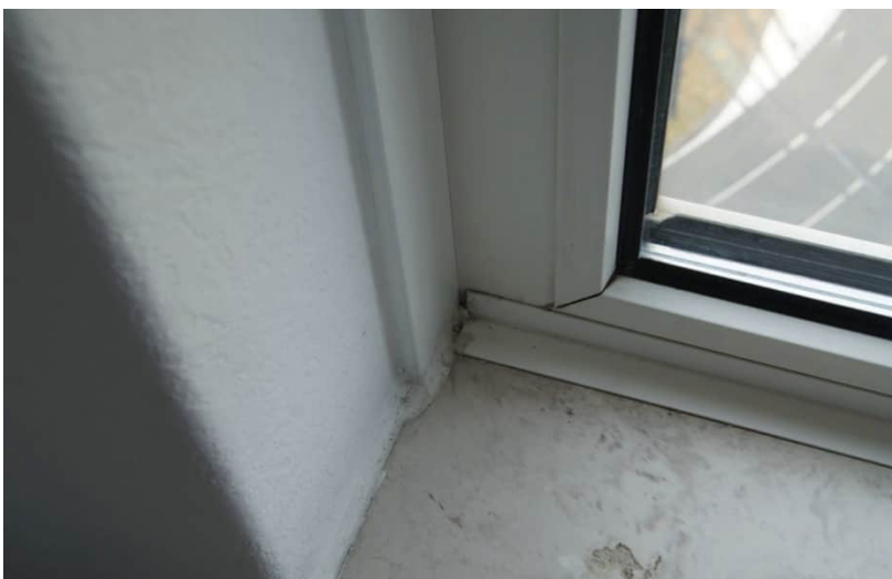
Afwerking met kunststof kozijn, eterniet vensterbank en witgeschilderde muur.
