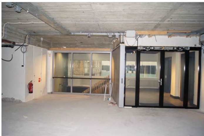
Het trappenhuis gezien vanaf de achtste bouwlaag vanaf de voorzijde.
