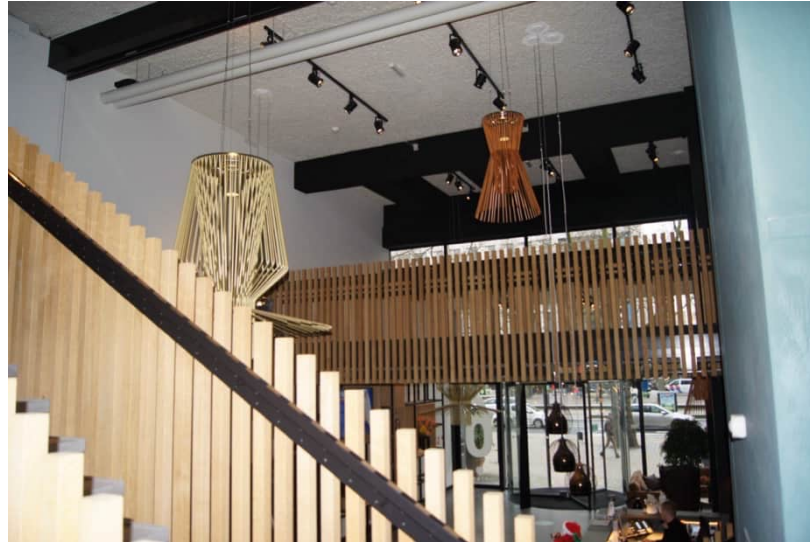
De hal met trappenhuis en vide in de entresol. De betonnen balklagen uit 1959 zijn zichtbaar. Het interieur is volledig vernieuwd in 2016-2018.
