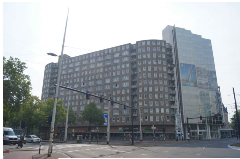
De later aangebouwde spiegelende kantoorflat dissoneert in volume, vorm en materiaal met de Pompenburgflat.
