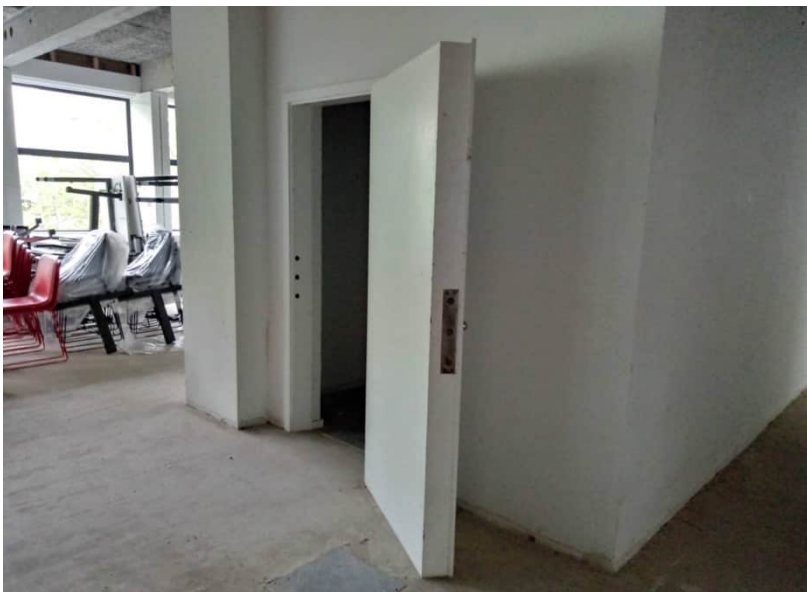
Op elke verdieping bevindt zich een kluis met oorspronkelijke kluisdeur. De kluizen zijn niet meer in gebruik.
