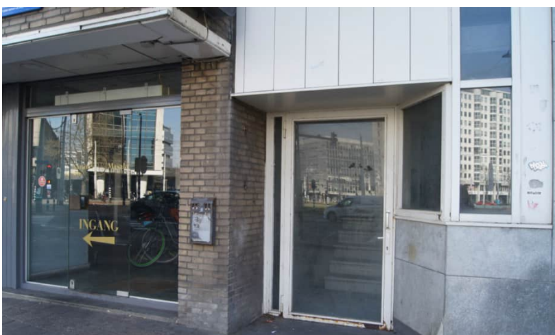
Aansluiting Pompenburgflat en Aegon-flat.
