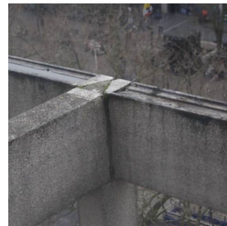
De betonnen pergola van boven gezien.
