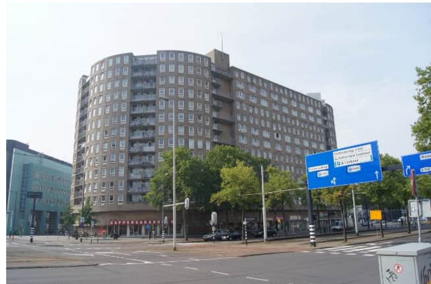
Zijde Pompenburg, gezien vanuit het noordoosten.
