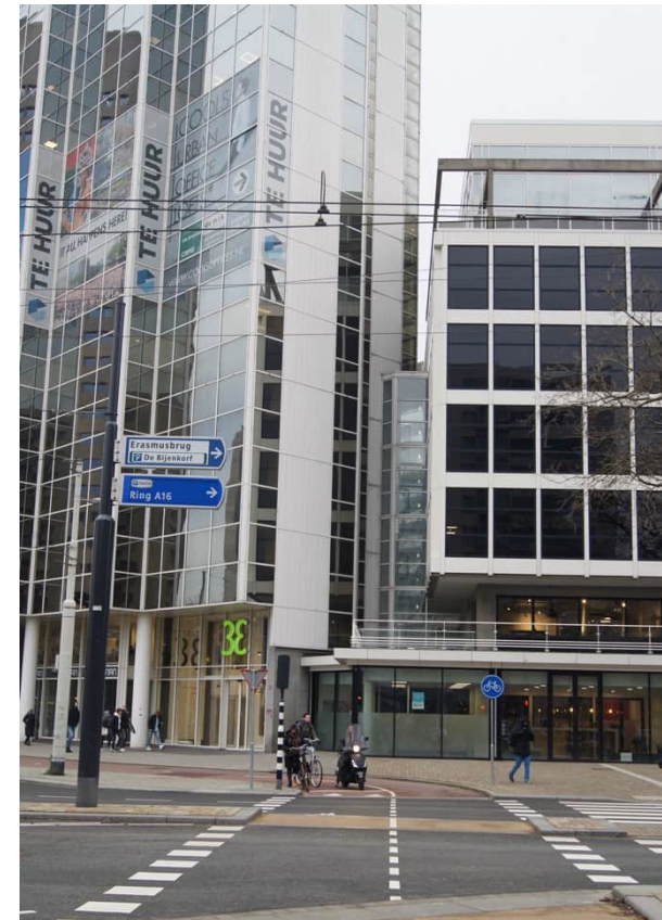
Aan de linkerzijde is Coolsingel 6 verbonden met de Hofpleinflat door een glazen plint en trappenhuis.
