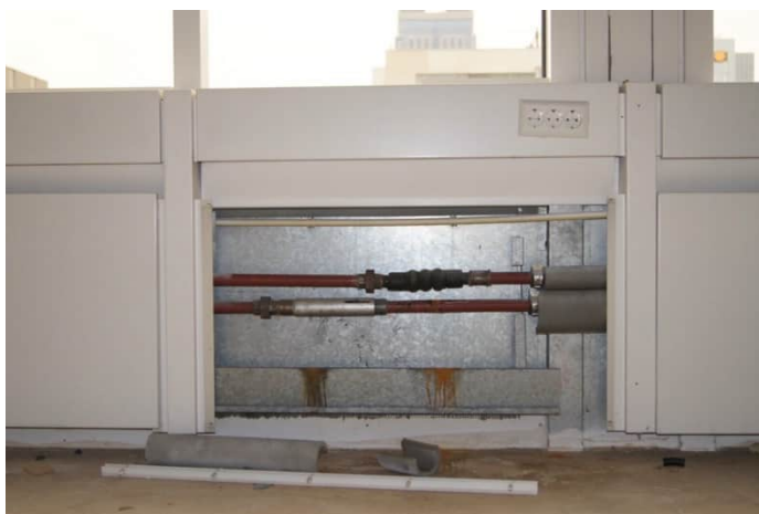
Achter de aluminium bekleding van de borstwering van de achtste bouwlaag bevinden zich buizen.
