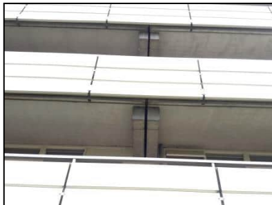
Figuur 13. Open dilatatievoegen.
