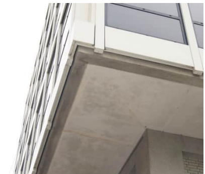
Aansluiting van pui op gevel
