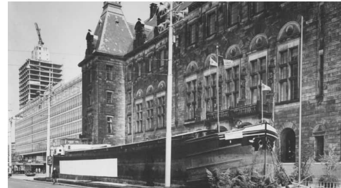
De Coolsingel met links het stadhuis, 1975. Daarachter de in aanbouw zijnde Shell-toren aan het Hofplein. Collectie topografie Rotterdam. Bron: Stadsarchief Rotterdam.
