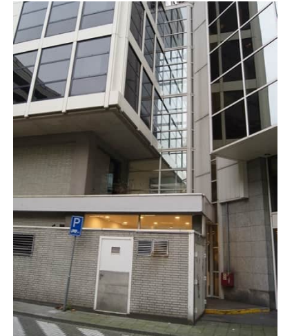
In een bakstenen uitbouw bevindt zich de ingang naar de kelder.
