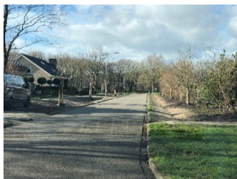
Hemelwater van openbare verharding stroomt via een uitstroomvoorziening (verlaagde trottoirband) naar een verlaagde berm (Blauwe hof 60 e straat).
