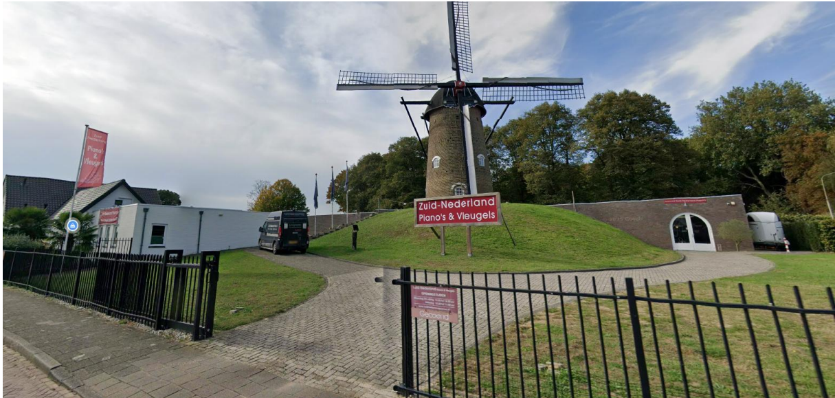
Aanzicht plangebied vanaf Graafsweg (bron: Google Maps)
