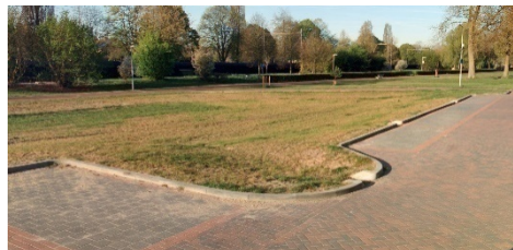
Hemelwater van bestaande openbare verharding is afgekoppeld van riolering en loost via een uitstroomvoorziening (verlaagde trottoirband) op een waterbergende wadi (Homberg 14 e straat)
