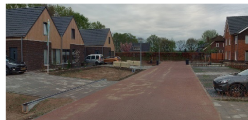
Hemelwater van nieuw aangelegde openbare verharding is niet-aangekoppeld aan riolering, maar loost links op een waterbergende wadi (Steenuil Bergharen).
