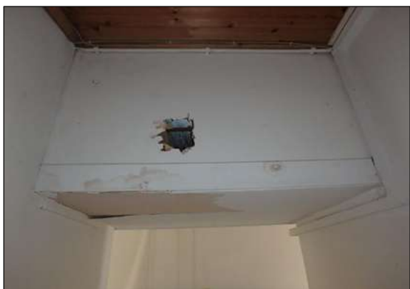
Omtimmering in gang Niet asbestverdacht
