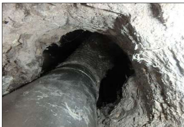
doorvoeren Geen asbestverdacht materiaal aangetroffen
