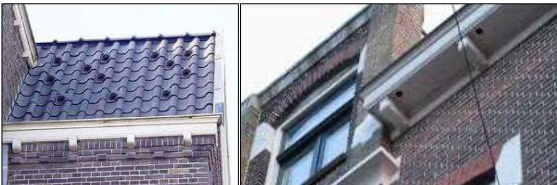
Figuur 18: Nestpan voor de gierzwaluw (links) en gaten in dakgootomlijsting (rechts).
