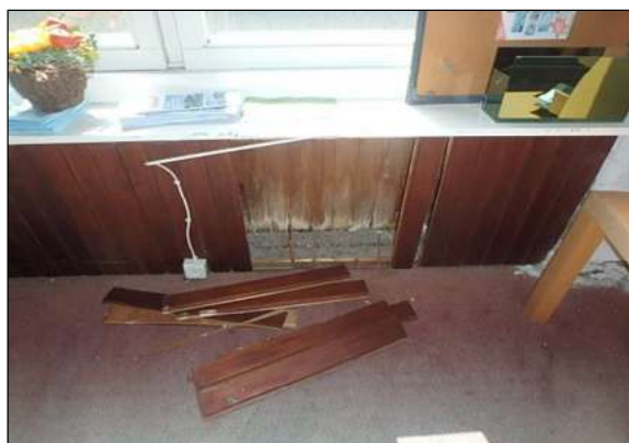
Achter voorzetwanden Geen asbestverdacht materiaal aangetroffen
