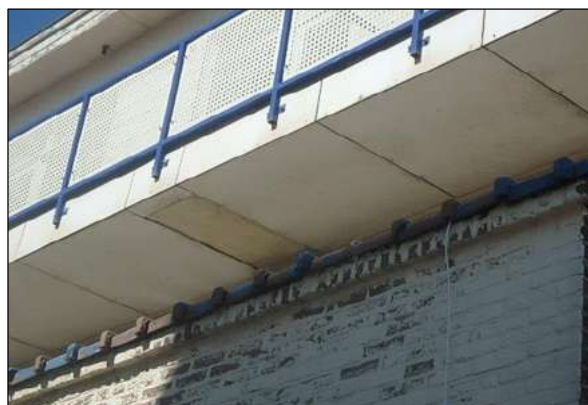
onderzijde balkons, afgewerkt met trespas Niet asbestverdacht
