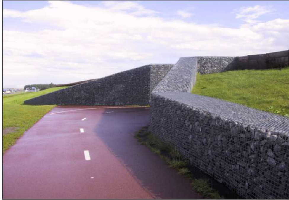
Schanskorven als grondkering
