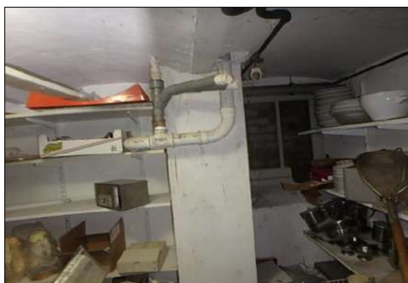
Kelder, leidingwerk, pvc Niet asbestverdacht
