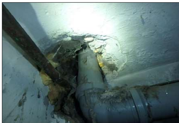
Doorvoeren Geen asbestverdacht materiaal aangetroffen
