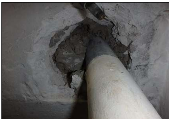
Doorvoeren Geen asbestverdacht materiaal aangetroffen
