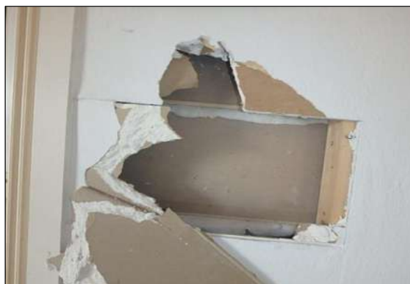
Tussenwanden Geen asbestverdacht materiaal aangetroffen
