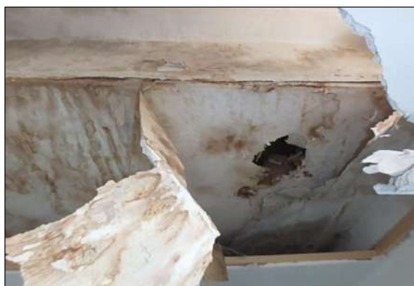
Wc, Plafond afgewerkt met gipsplaten Niet asbestverdacht
