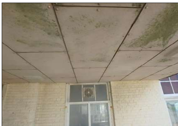
Entree, overstek, afgewerkt met trespas Niet asbestverdacht
