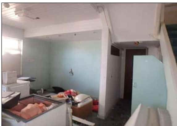
Begane grond, wanden afgewerkt met hout Niet asbestverdacht
