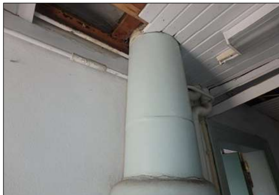
Gang, buis naar bovenliggende verdieping Geen asbestverdacht materiaal aangetroffen
