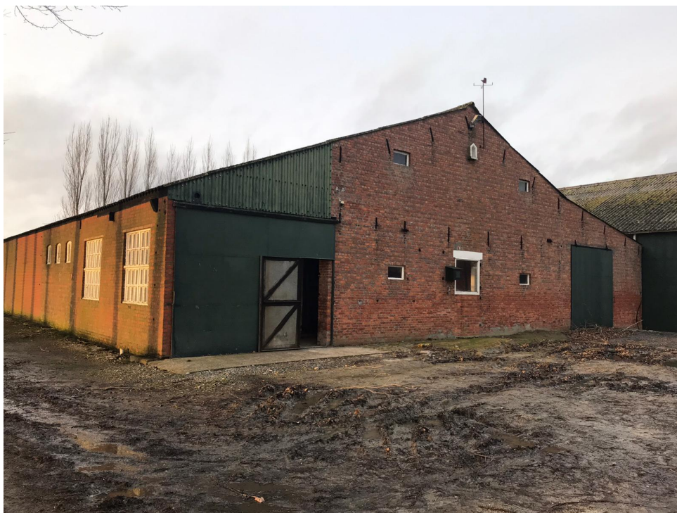
Foto 1. Te slopen schuur.
