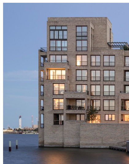
geveldiepte door accenten in volume Tuborg Strandeng, Lundgaard & Tranberg
