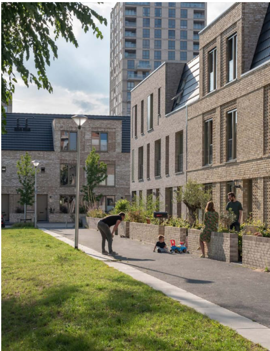
nieuwbouw met eigentijds karakter Hogekwartier, Amersfoort, KCAP
