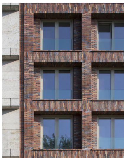
sterke gelaagtheid in gevels ✓ Houthavens, Amsterdam, Marcel Lok
