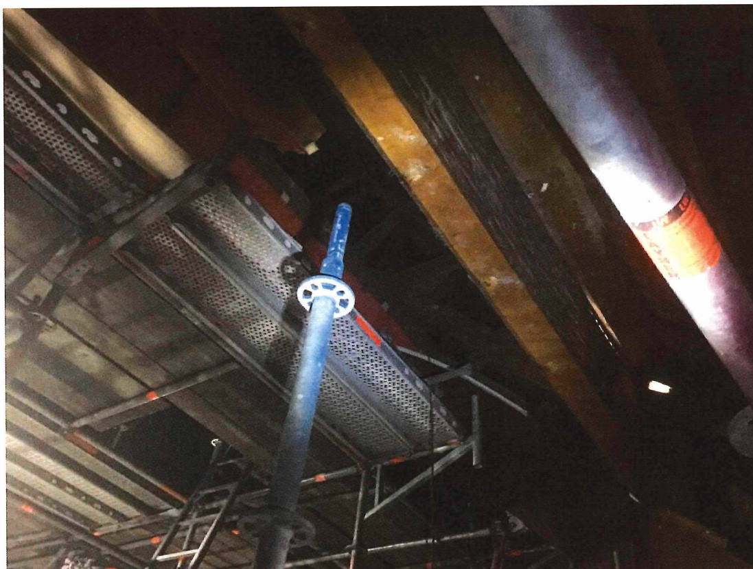
Foto 2001 ondersteuning door steiger van spantboog (onderzijde steiger halverwege kap)
