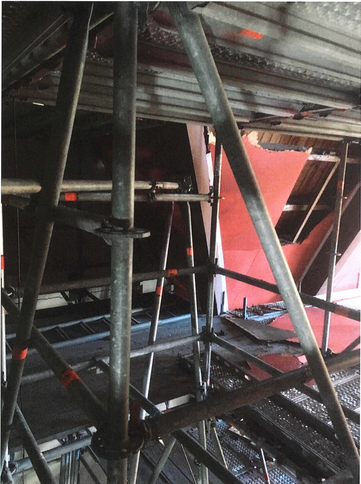
Foto 2022 ondersteuning steiger van spantboog (steiger halverwege kap)
