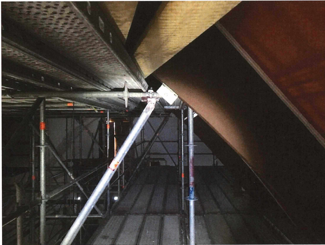
Foto 2012 gelijk aan foto 2013 ondersteuning steiger van spantboog (bovenzijde steiger halverwege kap)
