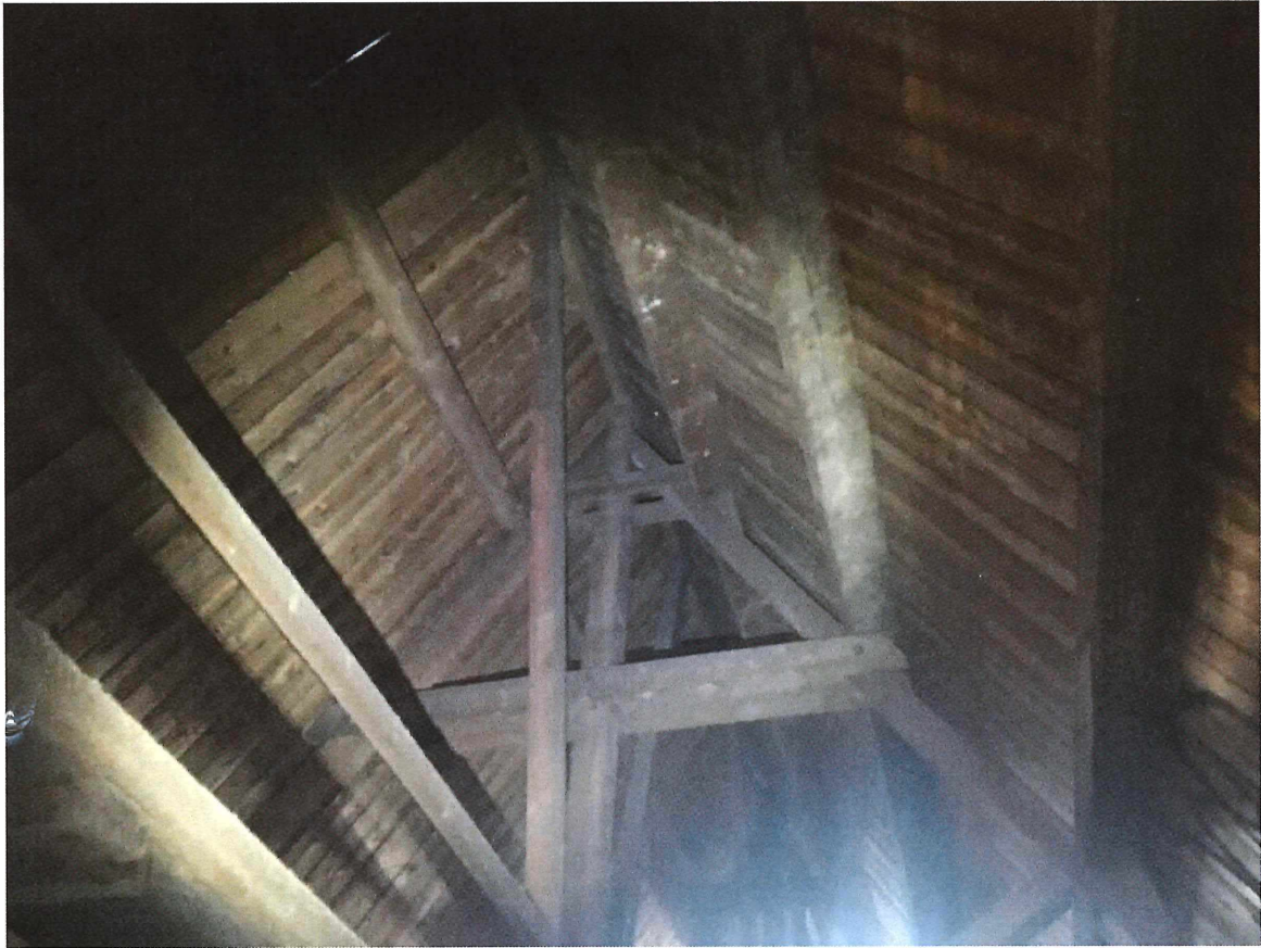
Foto 2015 kapconstructie boven spantboog ( vervolg van foto 2014 bovenin nok)
