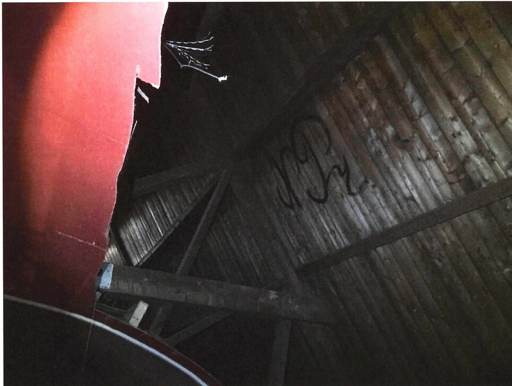
Foto 2017 kapconstructie boven spantboog
