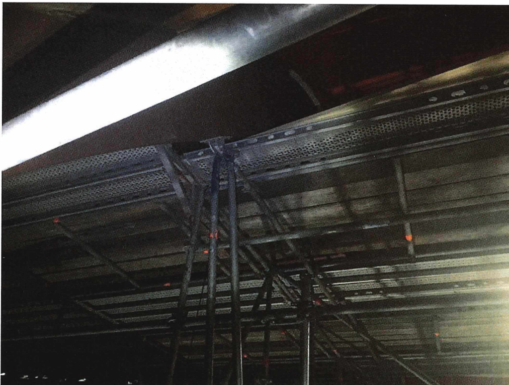
Foto 1999 ondersteuning door steiger van spantboog (onderzijde steiger halverwege kap)
