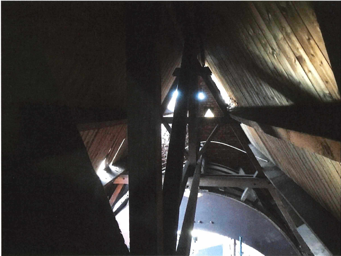
Foto 2021 kapconstructie boven spantboog
