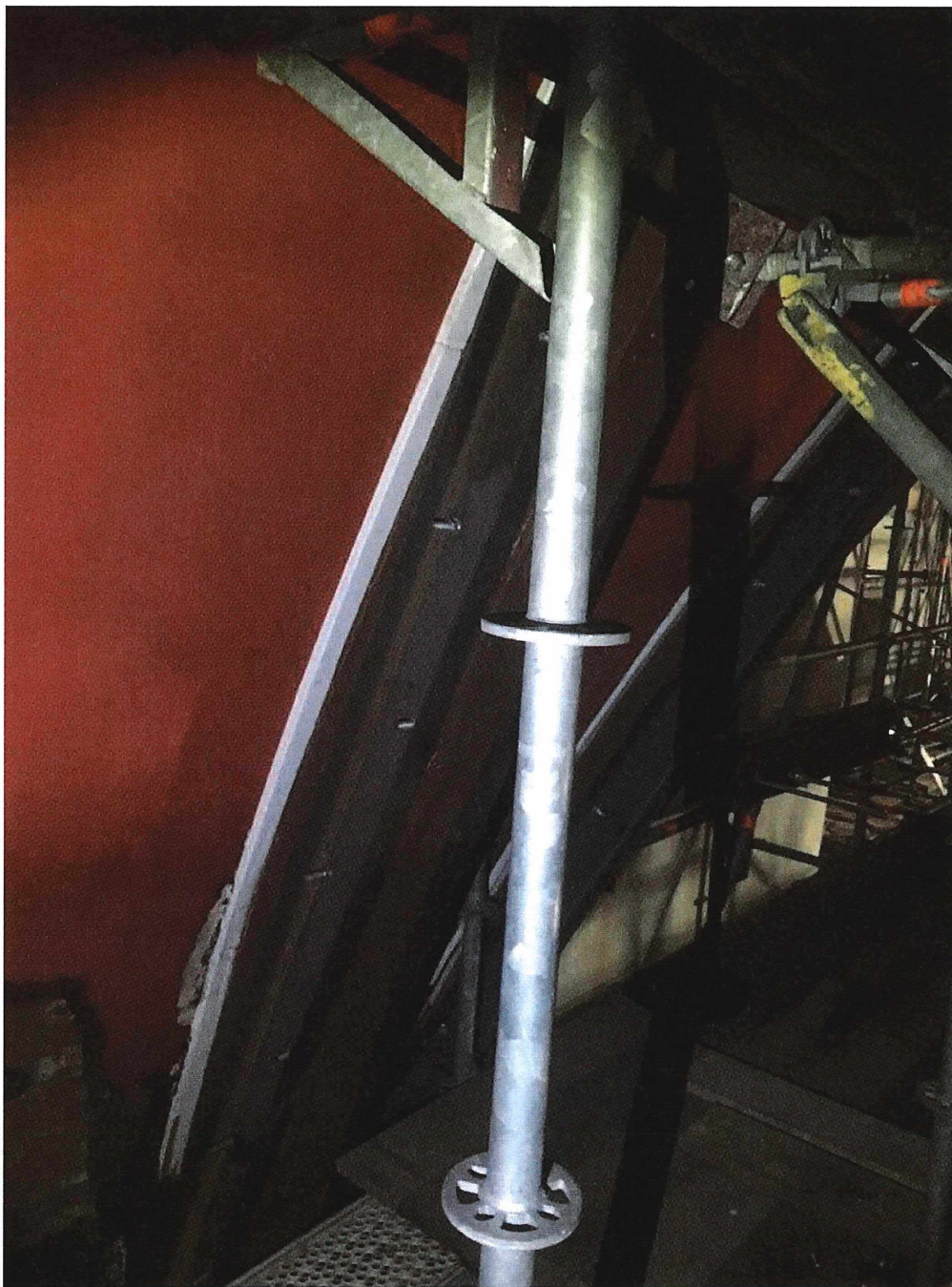
Foto 1986 onderzijde spant met UNP profielen
