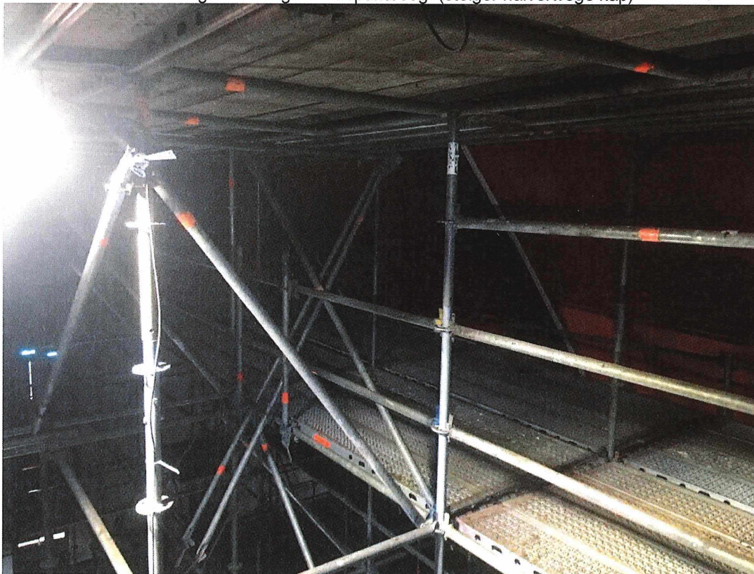
Foto 2011 ondersteuning door steiger van spantboog (schoren richting ondergrond)
