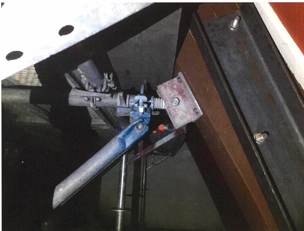
Foto 1990 spant halverwege kap bovenzijde UNP profiel- bevestiging steiger
