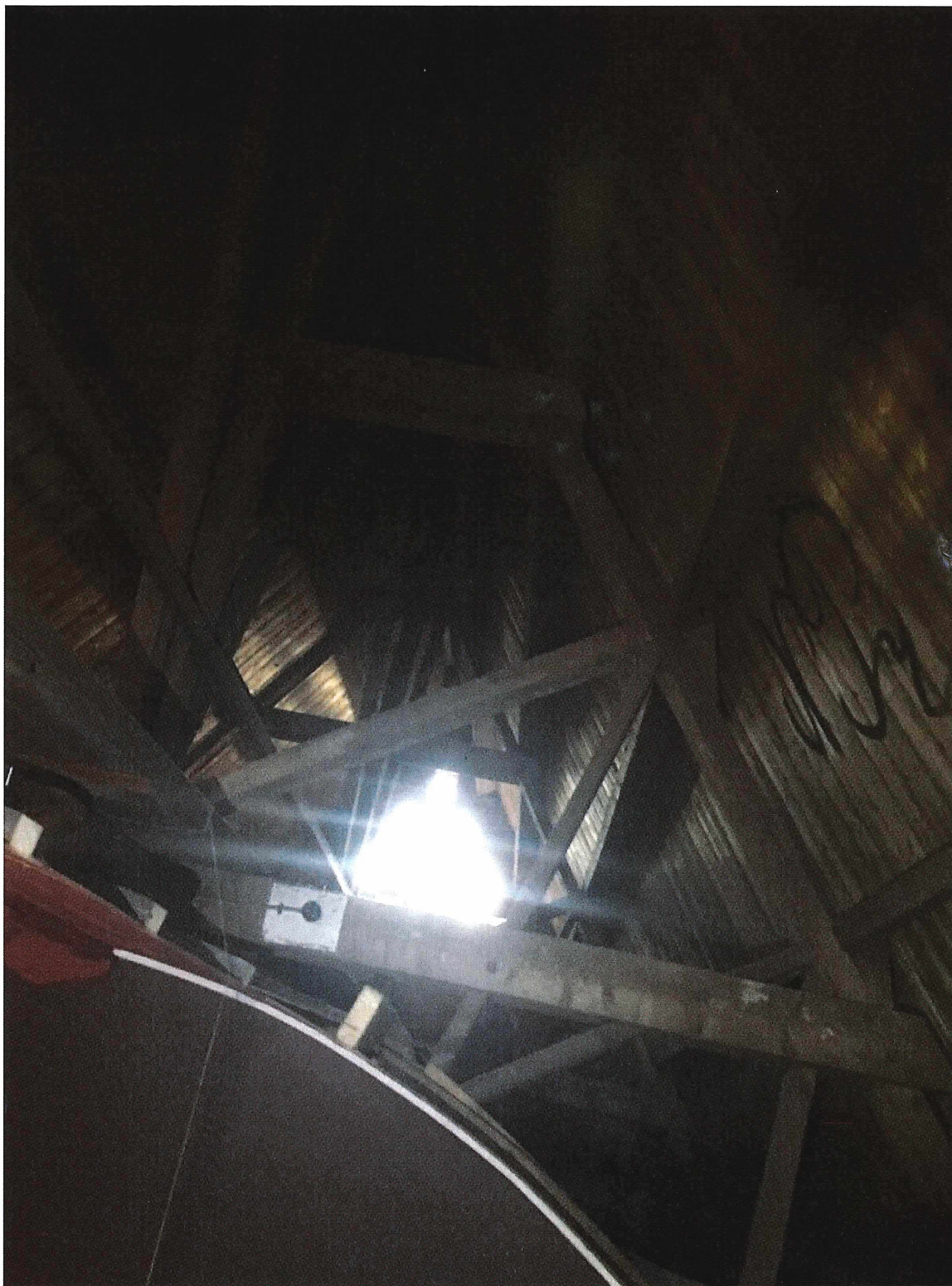
Foto 2014 kapconstructie boven spantboog
