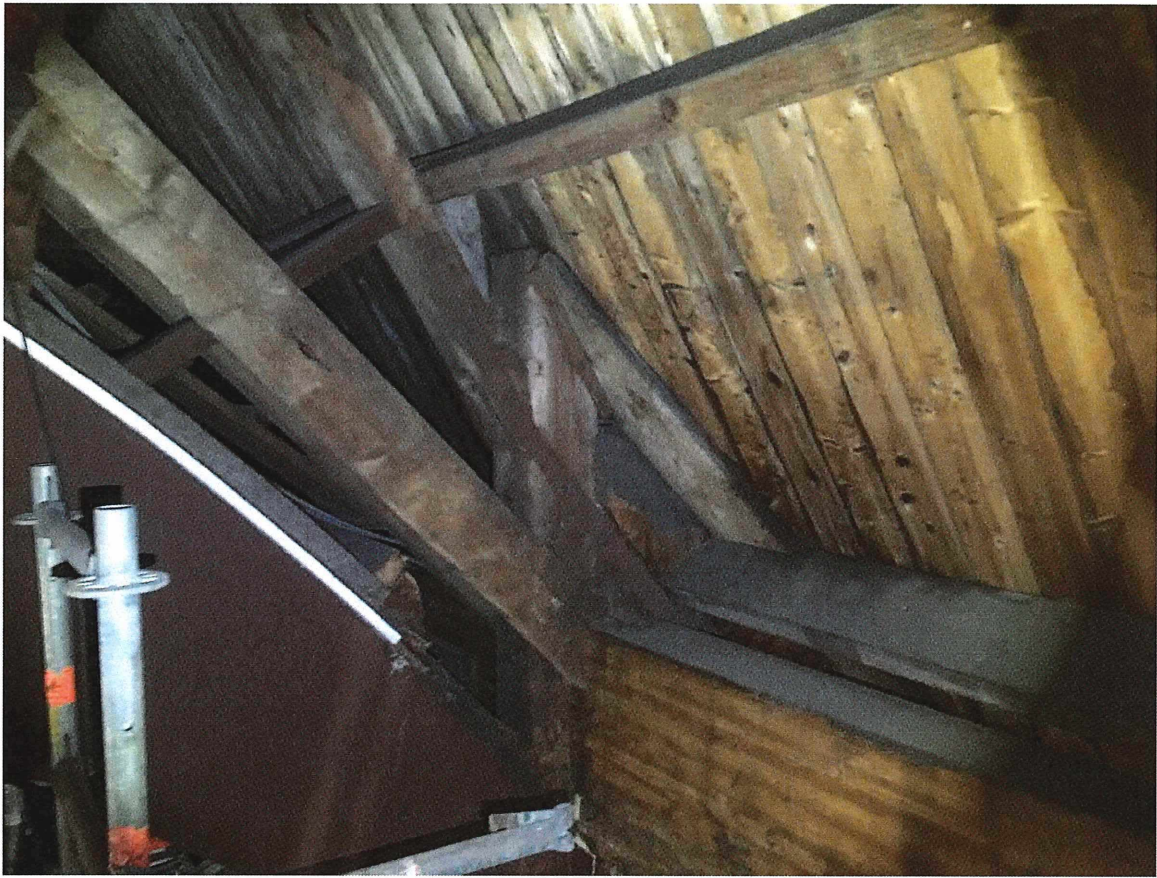
Foto 2019 gelijk aan foto 2020 kapconstructie richting bovenzijde spantboog
