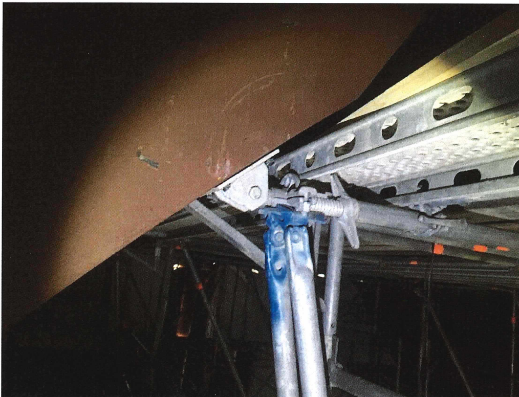
Foto 2010 ondersteuning door steiger van spantboog (steiger halverwege kap)
