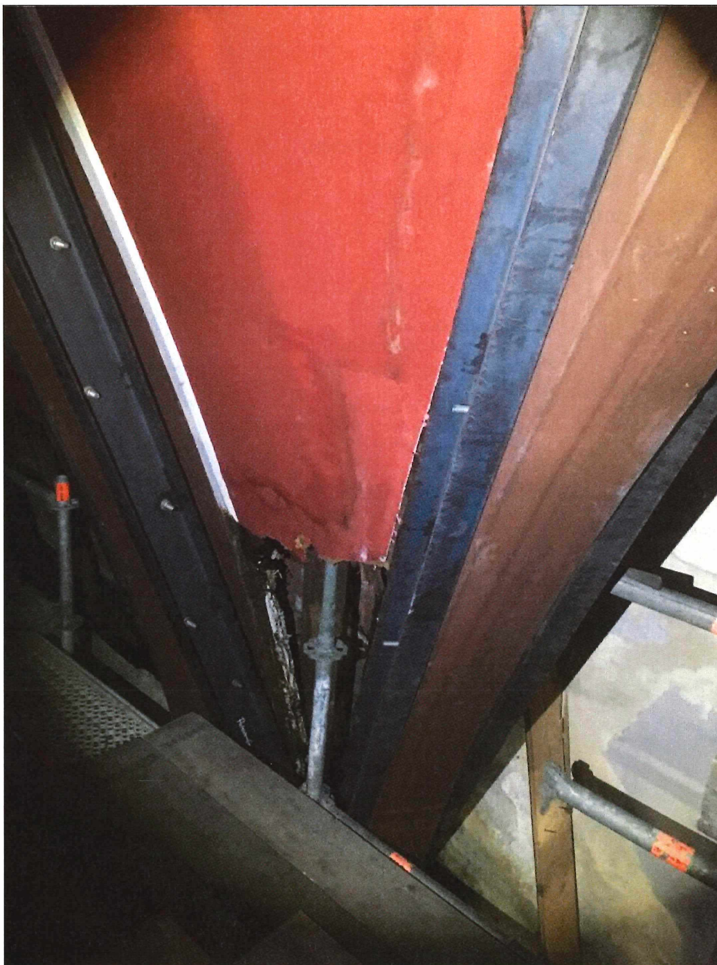
Foto 1985 onderzijde spant met UNP profielen
