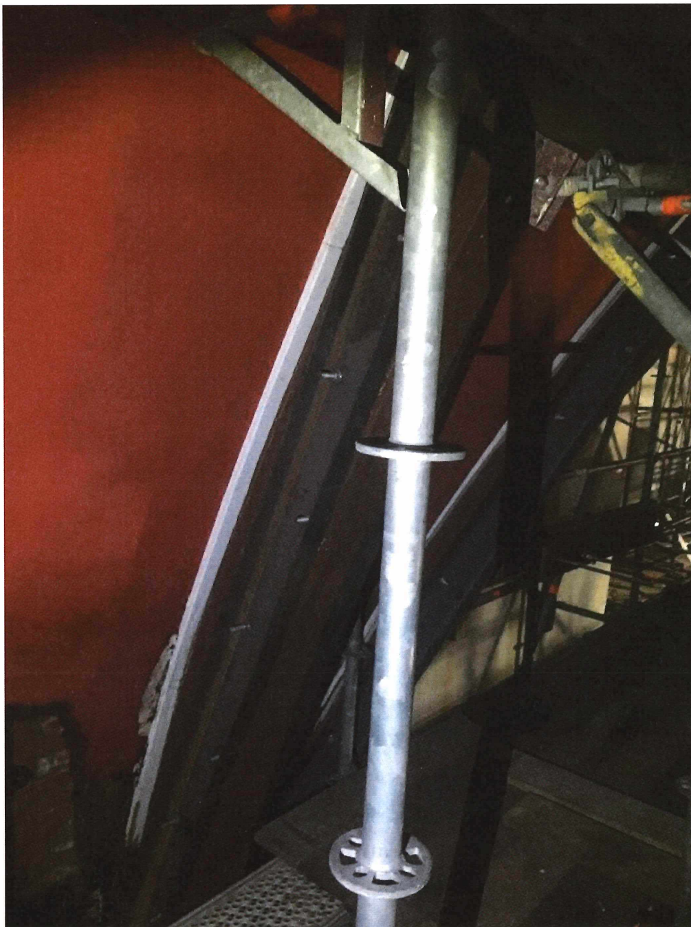
Foto 1987 onderzijde spant met UNP profielen
