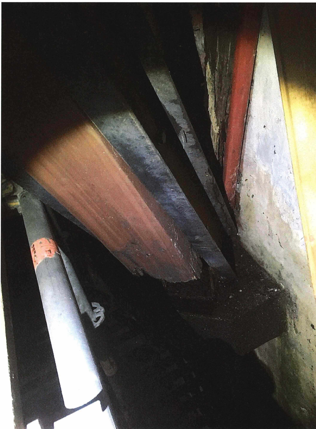
Foto 1989 onderzijde spant op ingebouwd vast steunpunt met UNP profielen
