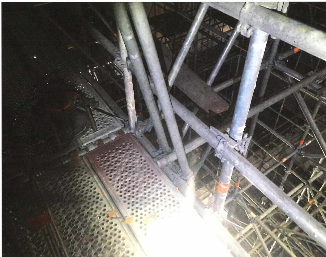
Foto 2008 gelijk aan foto 2009 steigerconstructie halverwege kap
