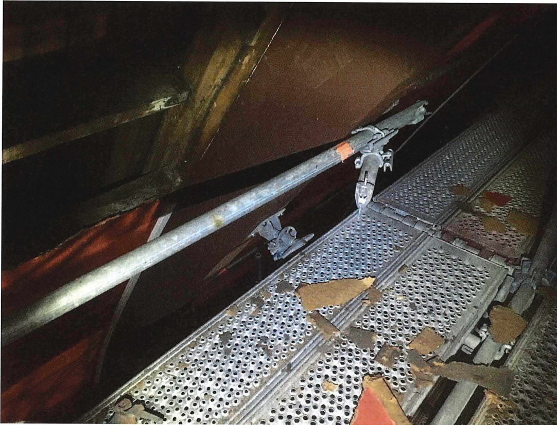
Foto 1998 ondersteuning door steiger van spantboog (bovenzijde steiger halverwege kap)
