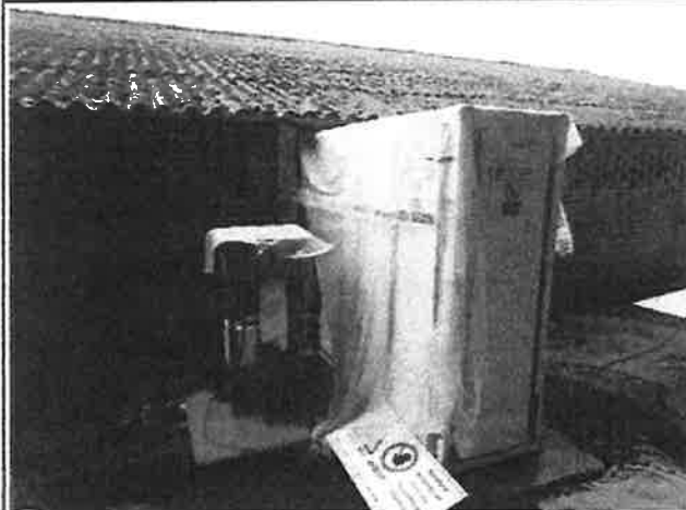
Foto 2. Opstelling 3-delige deco-sluis.
