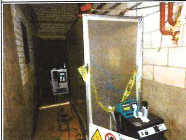
Foto 3. Opstelling containment, onderdruk registratie etc.
