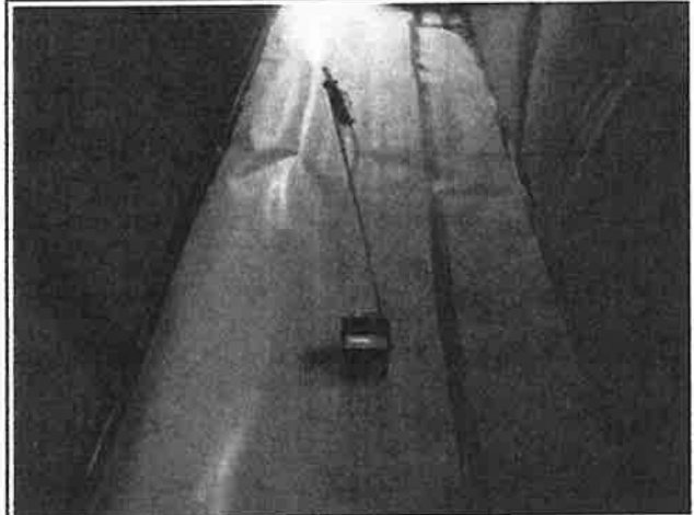
Foto 10. Opstelling meetpunt 2, pompnr. 58.
