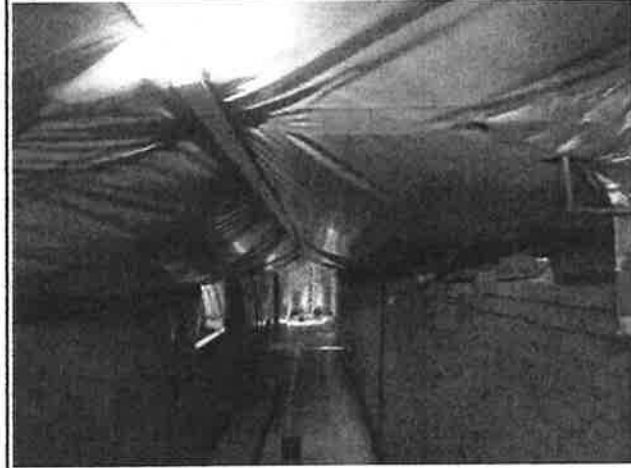
Foto 5. Folieplafond en deels foliewand.
