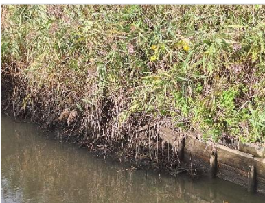
Figuur 2.6 Beschoeiing langs oever van westelijk gelegen watergang.
