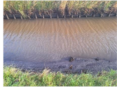
Figuur 2.5 Oever van westelijk gelegen watergang.
