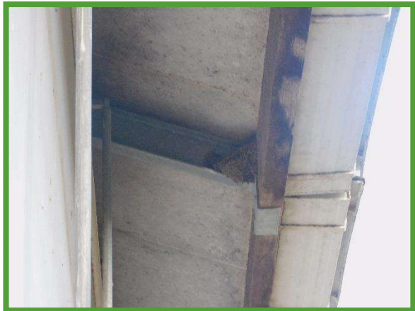
nest van boerenzwaluw aangetroffen onder dakoverstek van de te slopen loods
