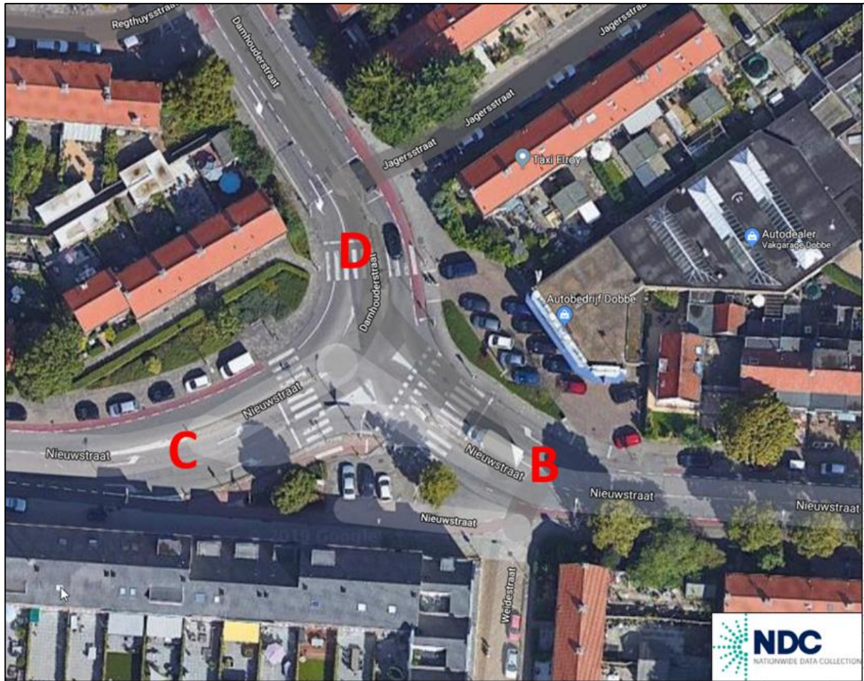
Figuur 2.3 Overzicht kruispunt Nieuwstraat - Damhouderstraat
