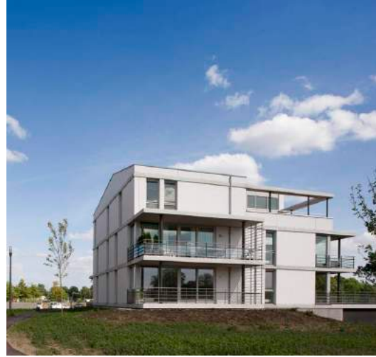
Appartementen centrum Nuenen
