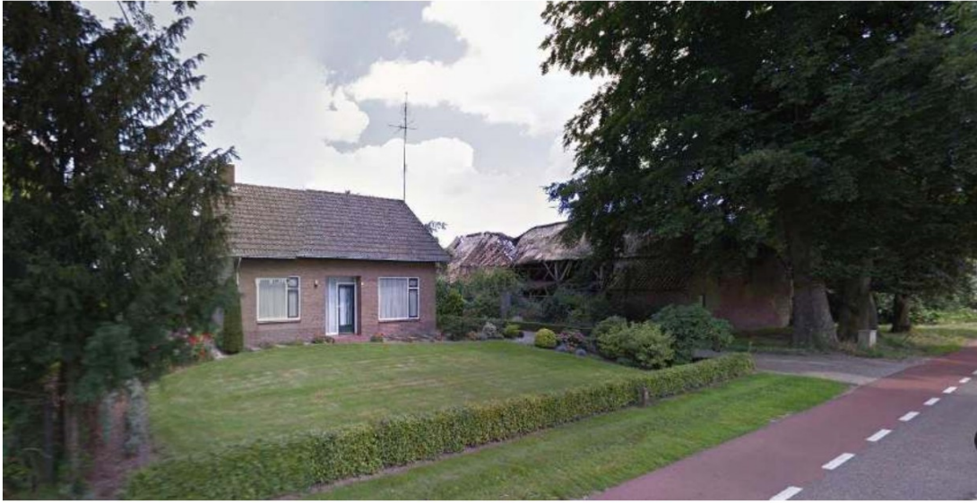
Vormalige agrarische bedrijfswoning Duifhuizerweg 22
