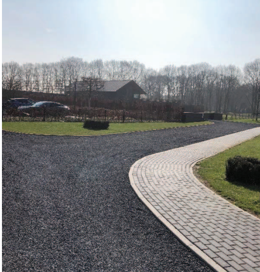
foto 7: beoogde bestrating oprijlaan (deels aanwezig)
