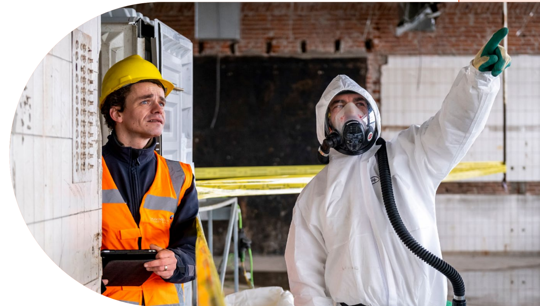
Jeroen Evers, toezichthouder asbest (ODZOB), bij een asbestsanering
