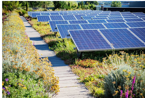
Groen dak en zonnepanelen in één
