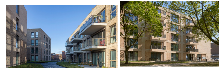
Balkons hangen boven het uitgeefbaar terrein Bron: Rietveld projects
