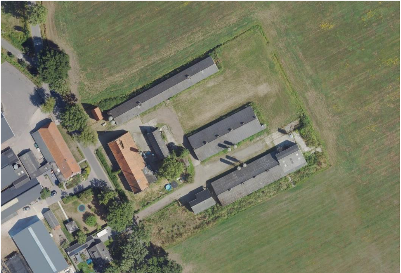
Figuur 2.1.4: Luchtfoto locatie Broekstraat 58 (bron: streetsmart.cyclomedia.com).
