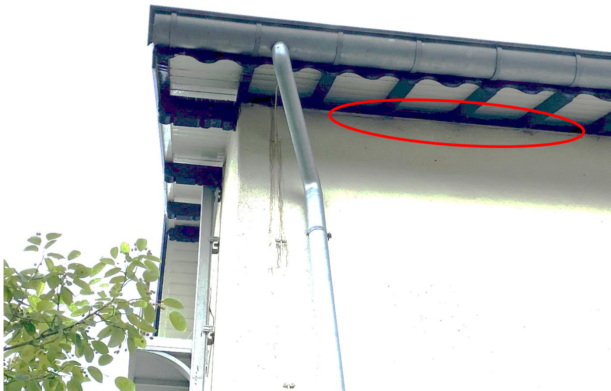
Foto 2: Onder het dakbeschot, op de aanlanding van de muur, zijn enkele openingen aanwezig die geschikte vaste rust- en verblijfplaatsen vormen voor vleermuizen
