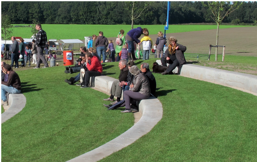
Zitranden in het talud (Zandweteringspark Deventer Feddes Olthof)
