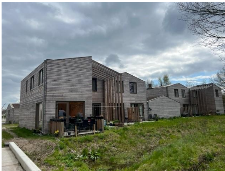
Figuur 1b Bron: eigen foto, bezoek flexwoonproject met Platform 31, april 2023, project in uitvoering https://buurtschapteveld.nl/
