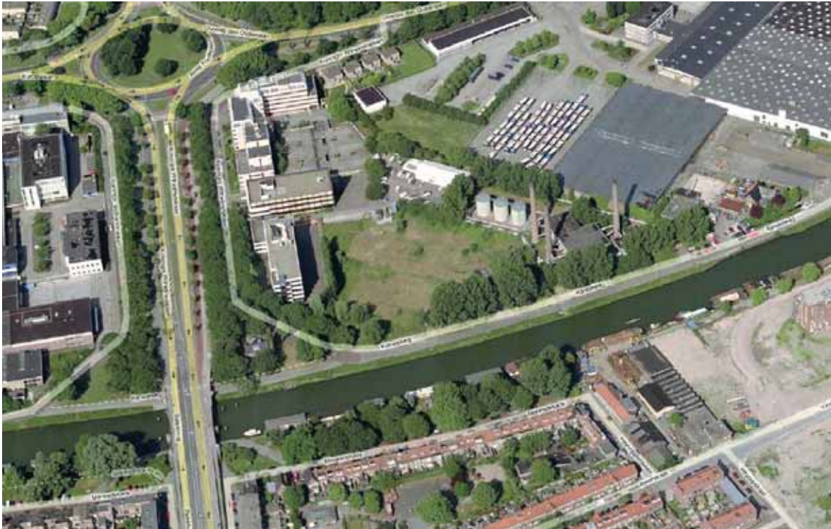
Afbeelding 3.1 Bestaande situatie plangebied
