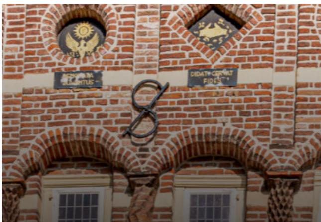
De fermesse als muuranker in kasteel Wijchen.
