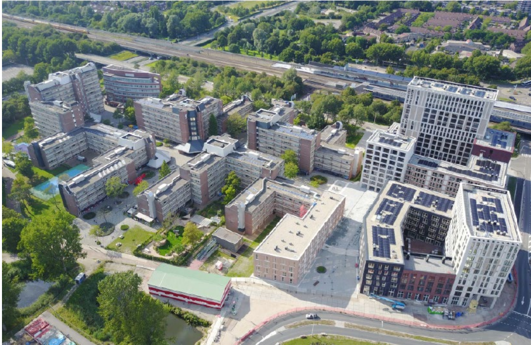
Afbeelding 7: Campus Diemen Zuid met links de 1 e fase (transformatie) en rechts de 2 e fase (nieuwbouw).
