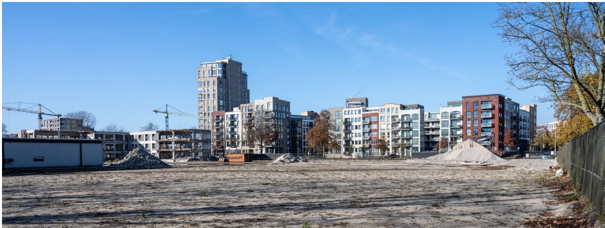
Afbeelding 1: Gebiedsontwikkeling Holland Park, met op de voorgrond bouwlocatie het Steigerblok en op de achtergrond de zuidrand van Holland Park Oost (opgeleverd) en de bouwkransen van Holland Park West (in aanbouw).
