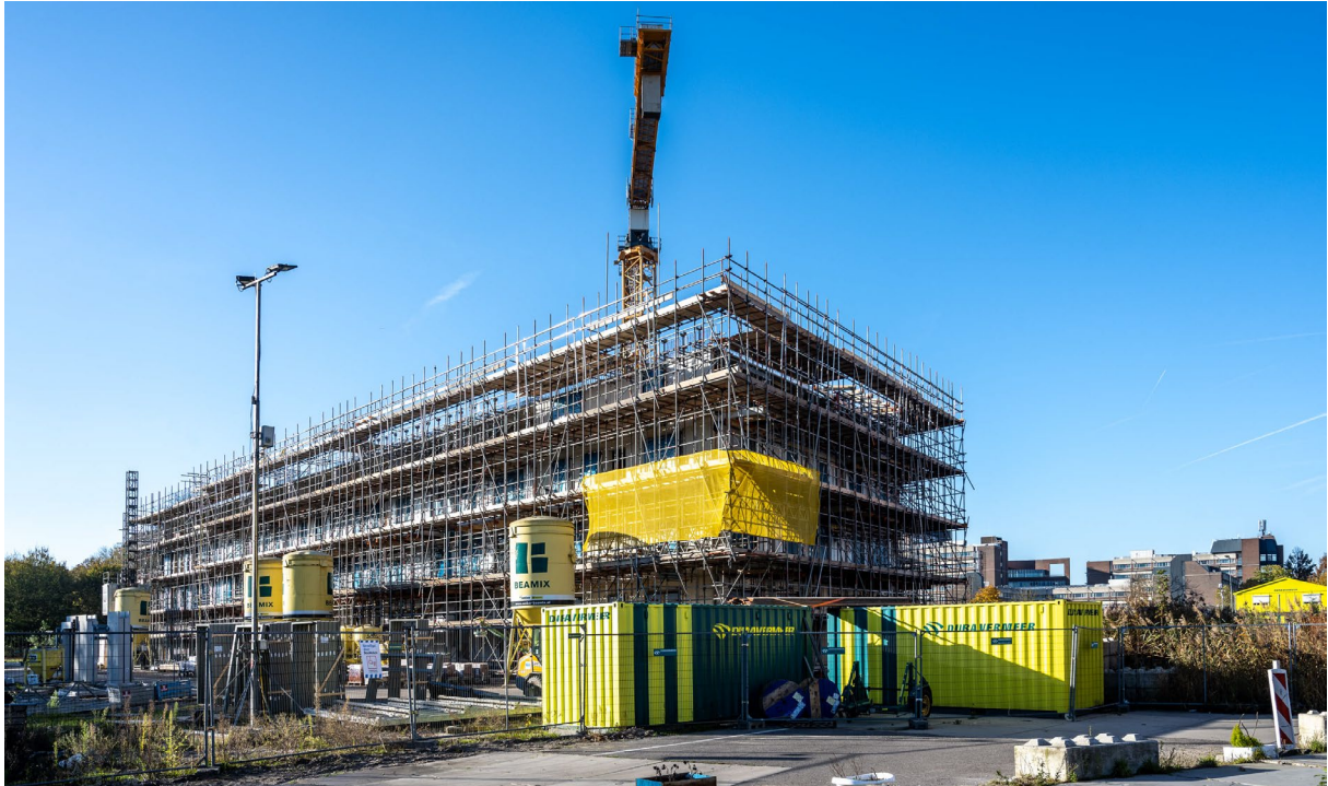
Afbeelding 4: Holland Park West fase 3A in aanbouw
