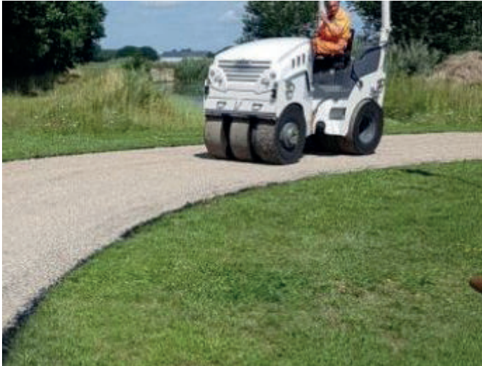
Voorzie asfaltpaden van een nieuwe slijtlaag
