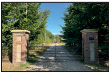
Voorbeeld van een toegangspoort (Hof te Dieren, Twickel)
