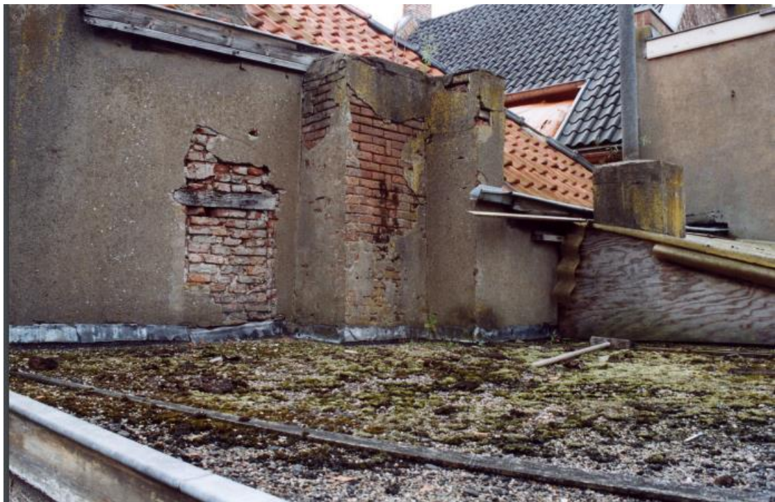
Westgevel (bron: Bouwhistorische Verkenning, 2002)
