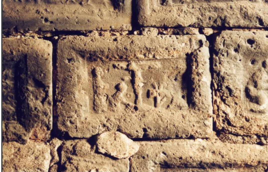
Detail haardsteen (bron: Bouwhistorische Verkenning, 2002)
