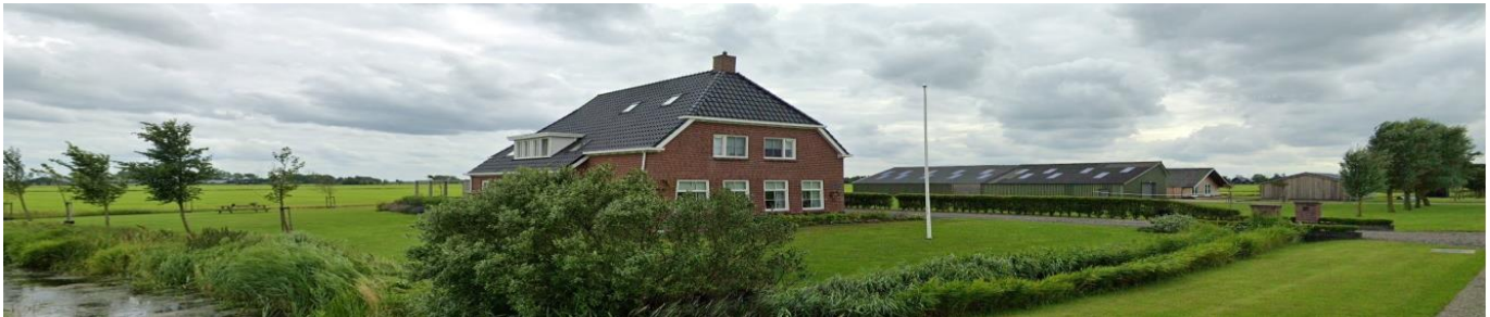
Figuur 2.1. Huidige situatie gezien vanuit het oosten.
