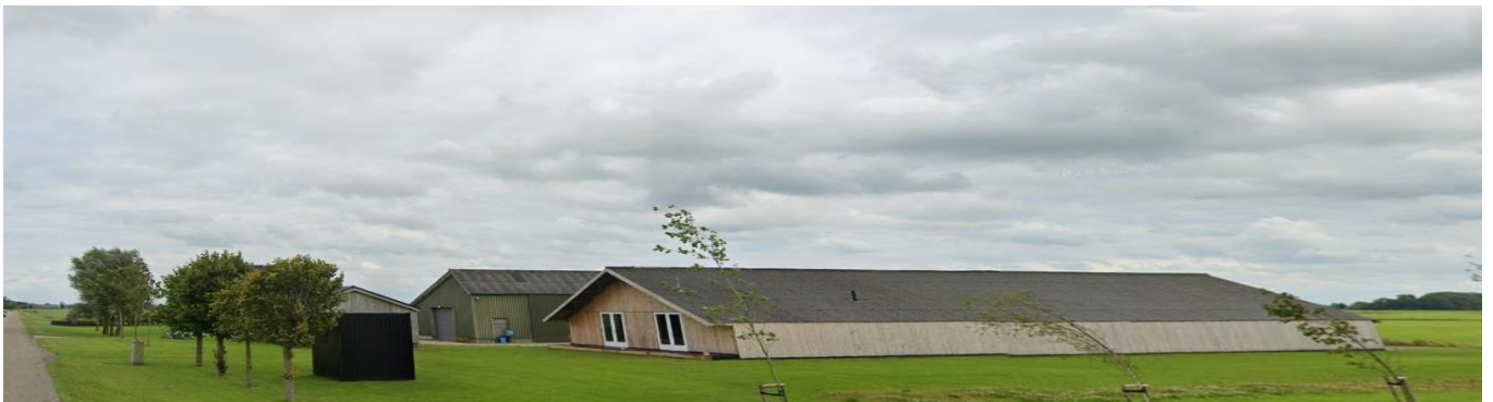
Figuur 2.2. Huidige situatie gezien vanuit het westen.
